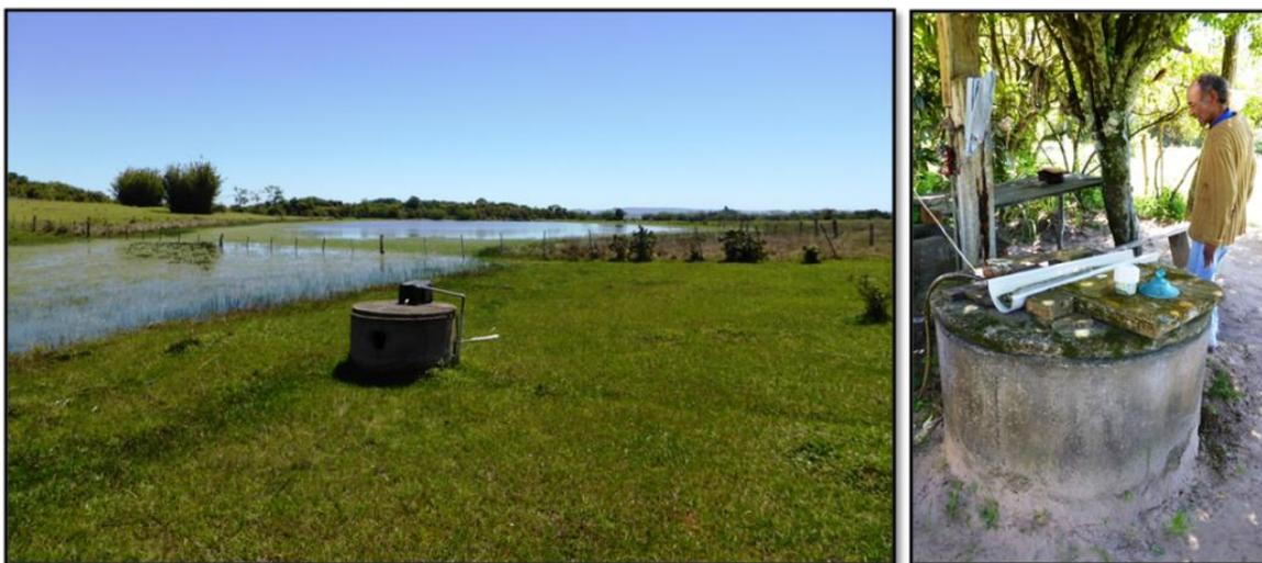
A mesma falta de estrutura também é encontrada nas captações de água em fontes. Buracos escavados pelos próprios moradores de forma precária, com cerca de 2 a 3 metros de profundidade, próximos, ou em meio ao banhado, sem tampas apropriadas, inexistência de lajes de proteção e muitos sem restrição de acesso de pessoas e animais ou com um perímetro de proteção com raio de somente dois metros. A Figura 14 apresenta registro fotográfico de captações de água em fontes, verificados na comunidade.
