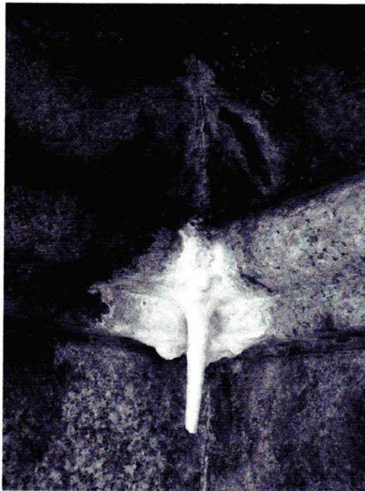
FIGURA 8 - Estalagmite composto por cimento carbonático hidratado originado a partir da dissolução e precipitação do cimento de fixação das chapas de mármore.
