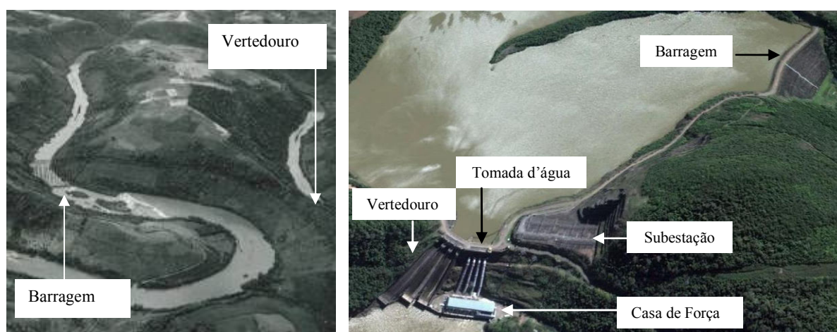
Figura 22: Vista de montante do Rio Jacuí antes da construção da Barragem (Fonte: Arquivo técnico Itaúba, 1972) e Arranjo geral do complexo Itaúba (Fonte: Google Earth, 2012)
