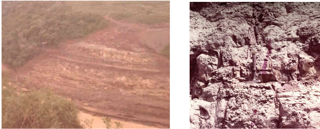
Figura 24: Vista da ombreira direita da barragem e detalhe do basalto amigdaloidal situado nas cotas 141 a 174 (Fonte: arquivo técnico de Itaúba, 1975)
