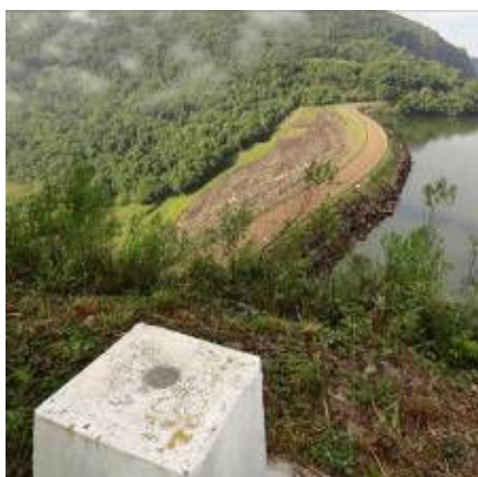
Figura 50: Marco de referência localizado na ombreira esquerda da Barragem de Itaúba
