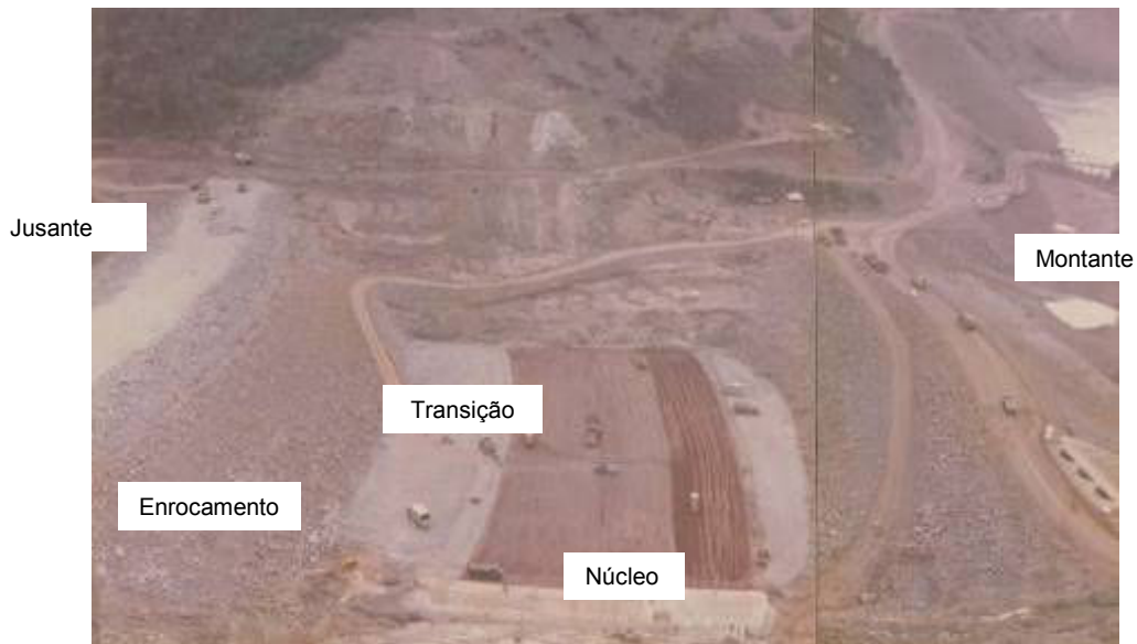
Figura 29: Execução das transições e núcleo da Barragem de Itaúba (17/05/1976)
