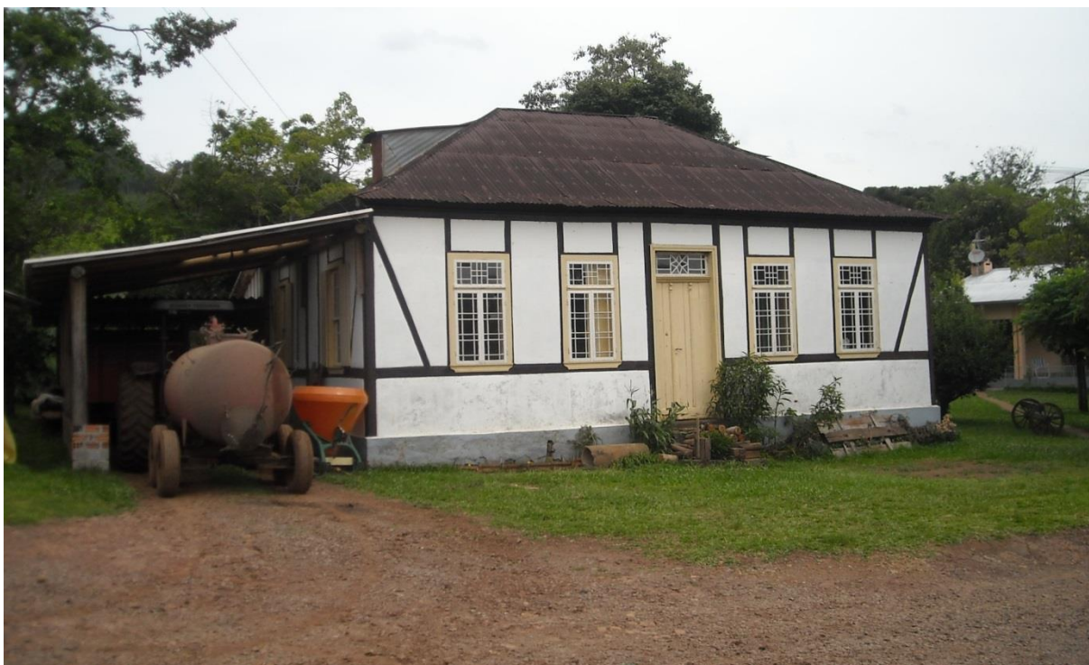
Figura 10 - O novo e o antigo se fundem nas formas e nos usos.
