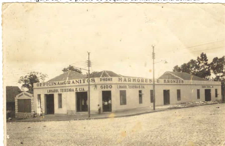
Figura 321 - O prédio de esquina da Marmoraria Lonardi.
