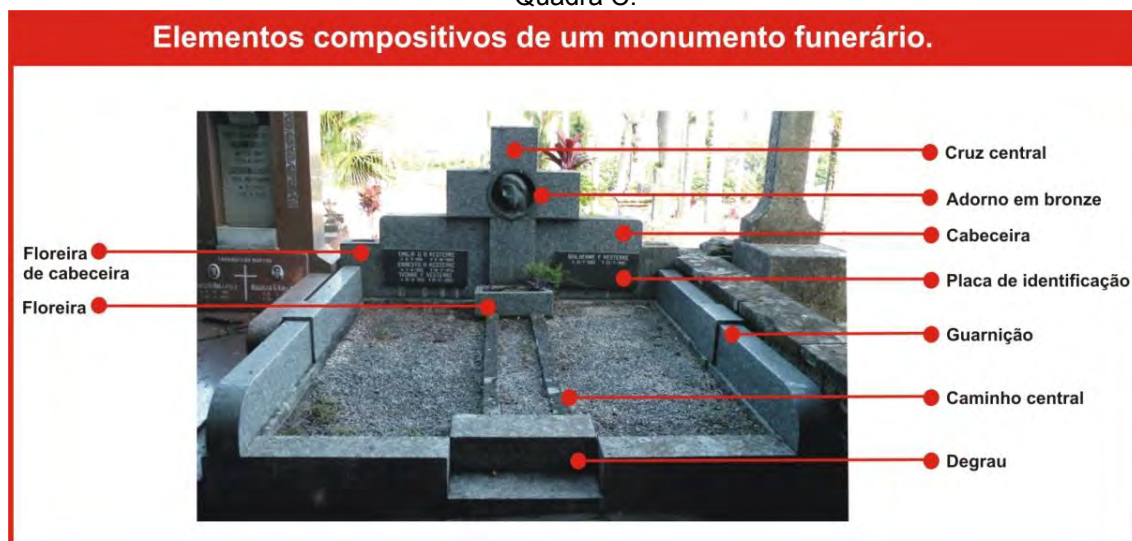
Figura 238 - Monumento Funerário Kesterke. Partes compositivas (granito). Cemitério São José I, Quadra C.
