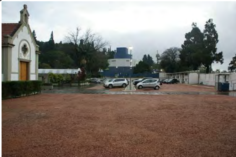
Figura 171 - O estacionamento do Cemitério São José II. Vista lateral.
