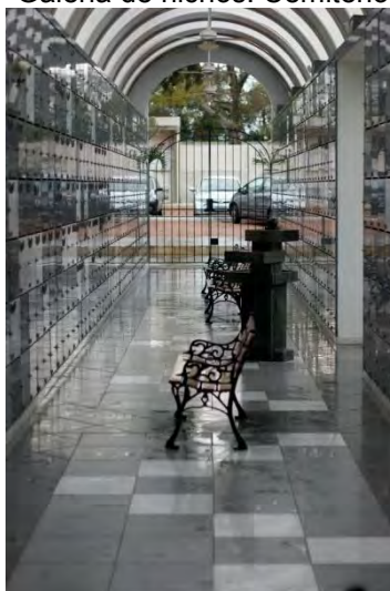
Figura 223 - Galeria de nichos. Cemitério São José II.
