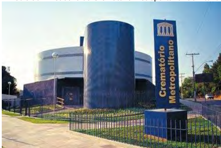
Figura 162 - Prédio administrativo do Crematório Metropolitano. Cemitério São José II.
