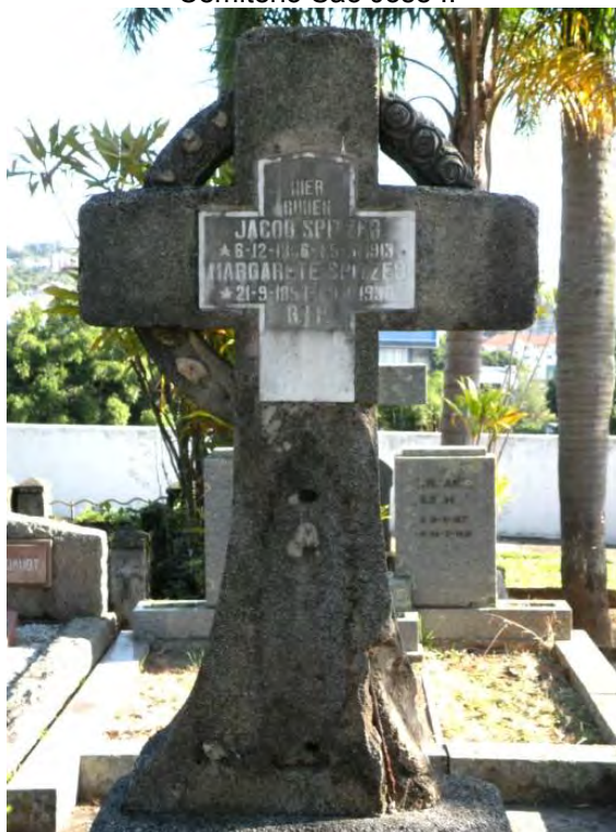
Figura 136 - Monumento Funerário Spitzer em concreto armado e revestido de cimento. Quadra D. Cemitério São José I.
