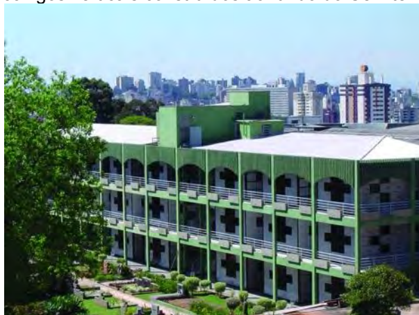
Figura 163 - Jazigos verticais construídos ao fundo do Cemitério São José II.
