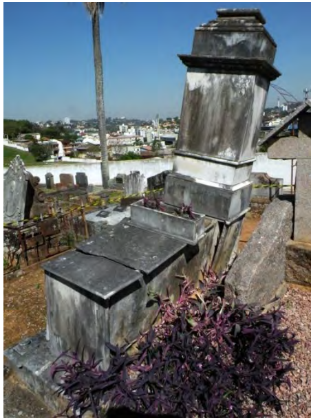
Figura 134 - Monumento Funerário Diehl em péssimo estado de conservação. Quadra E. Cemitério São José I.
