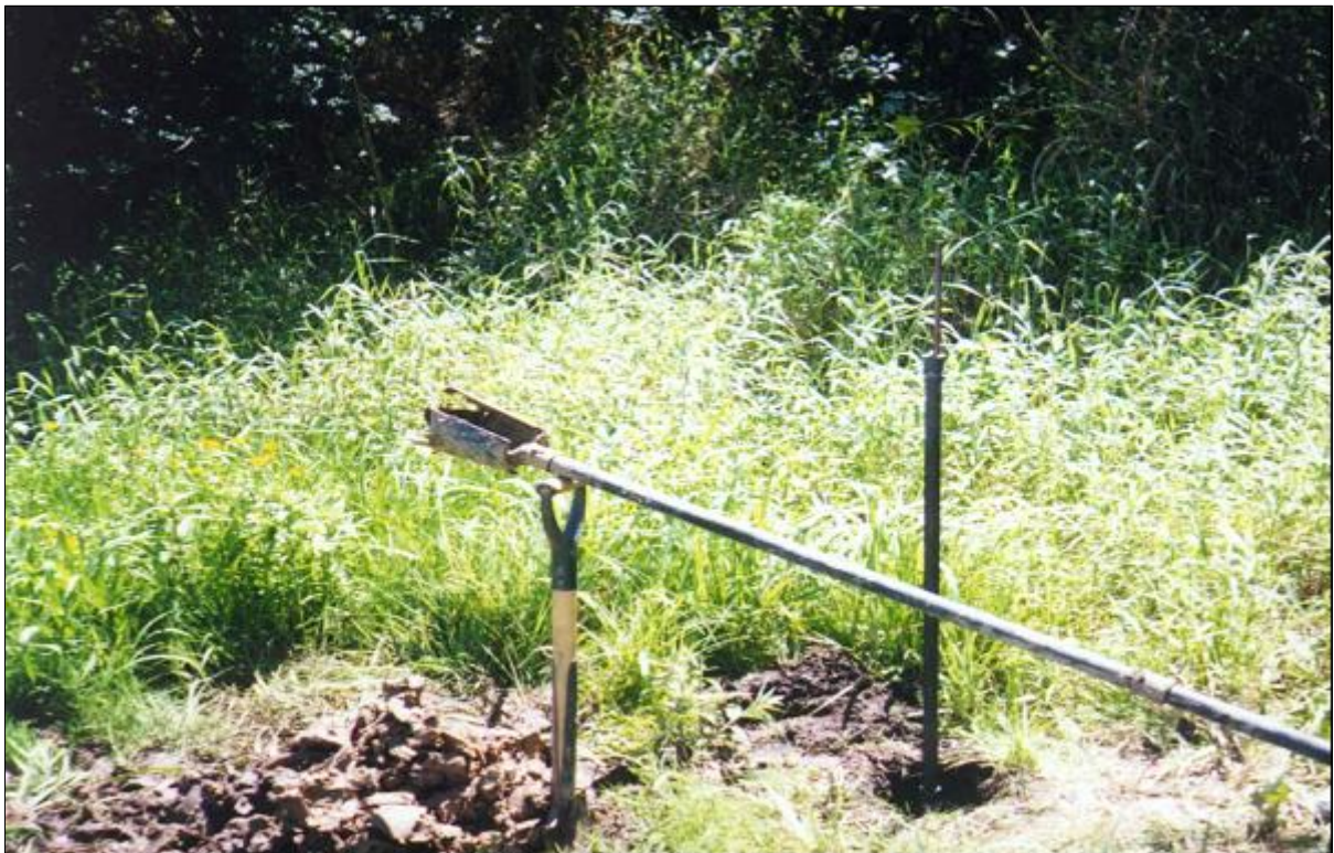
Figura 24: Vista das hastes de cravação, após a cravação do tubo “ Shelby ” no furo de sondagem, e vista do trado manual empregado para abrir este furo
