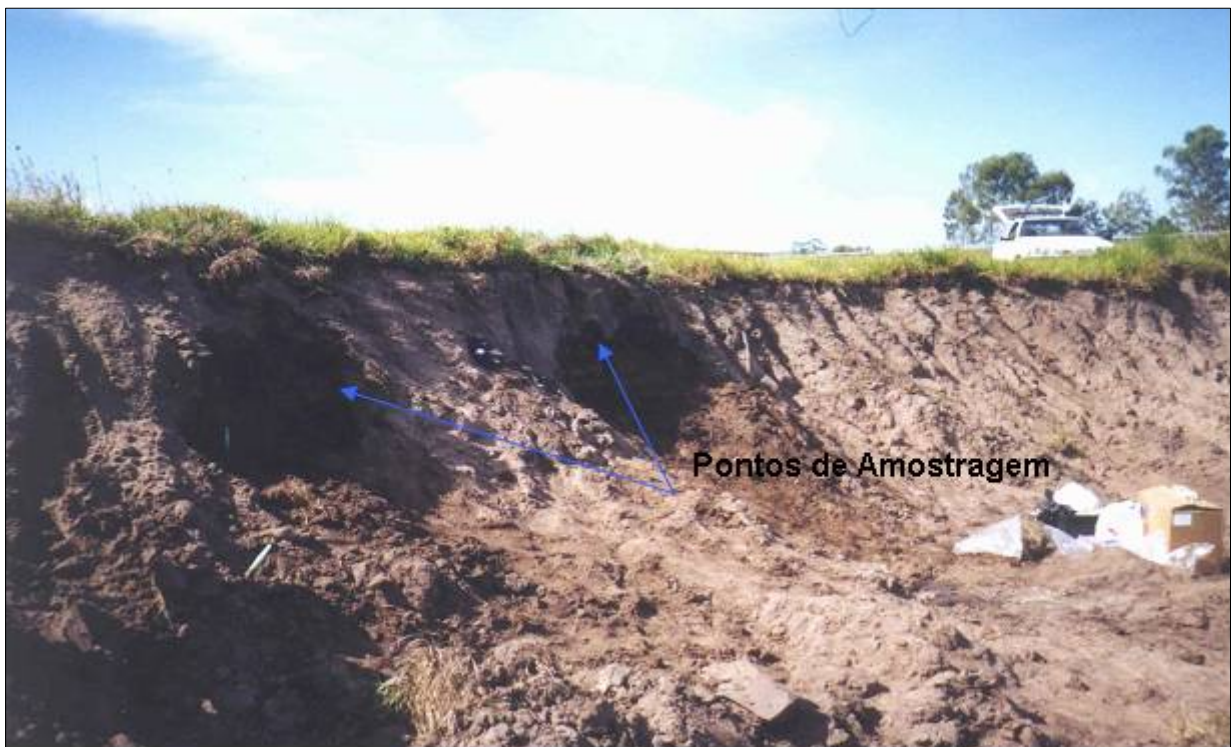
Figura 21: Pontos de amostragem do solo arenoso de Santo Antônio da Patrulha no talude de escavação
