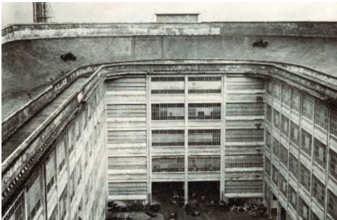
Figura 34 – Vista do pátio da fábrica
