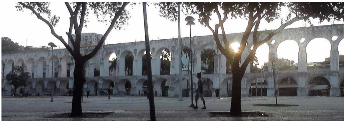
Figura 31 – Aqueduto Carioca transformado em via para bondes. Fonte: Foto do autor, 2014.
