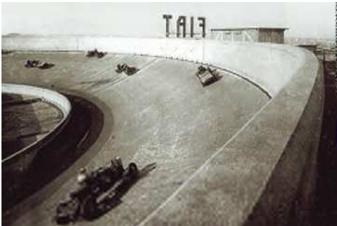
Figura 33 – Vista da Cobertura autopista da fábrica
