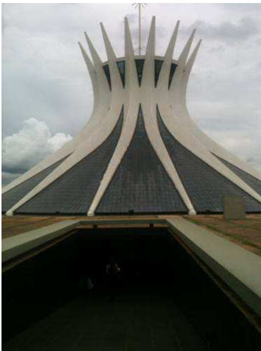
Figura 82 – vista do acesso da Catedral de Brasília Fonte: Foto do autor, 2014.
