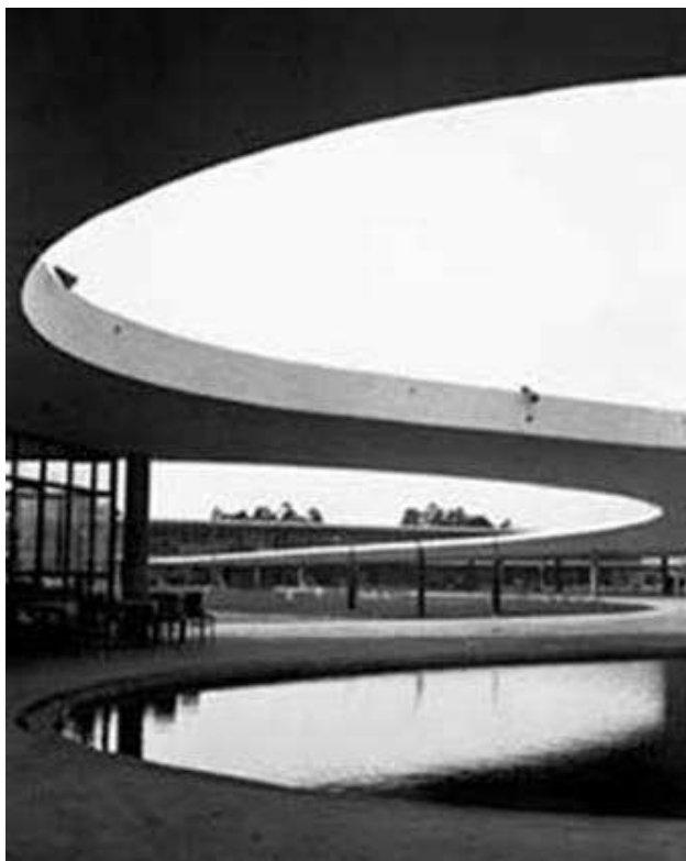
Figura 75 – Vista do espelho d'água e marquise
