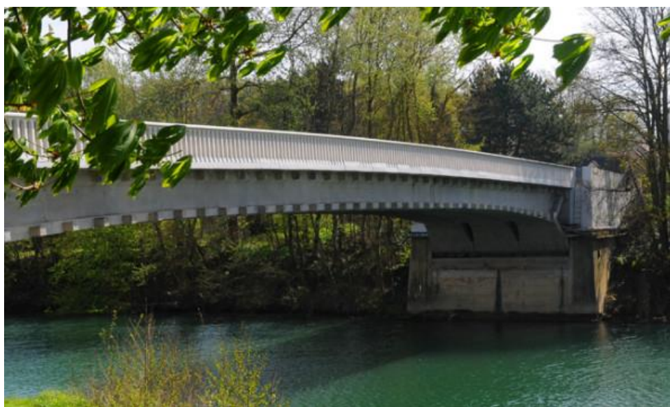
Figura 3 – Ponte de Luzancy sobre o rio Marne, na França
