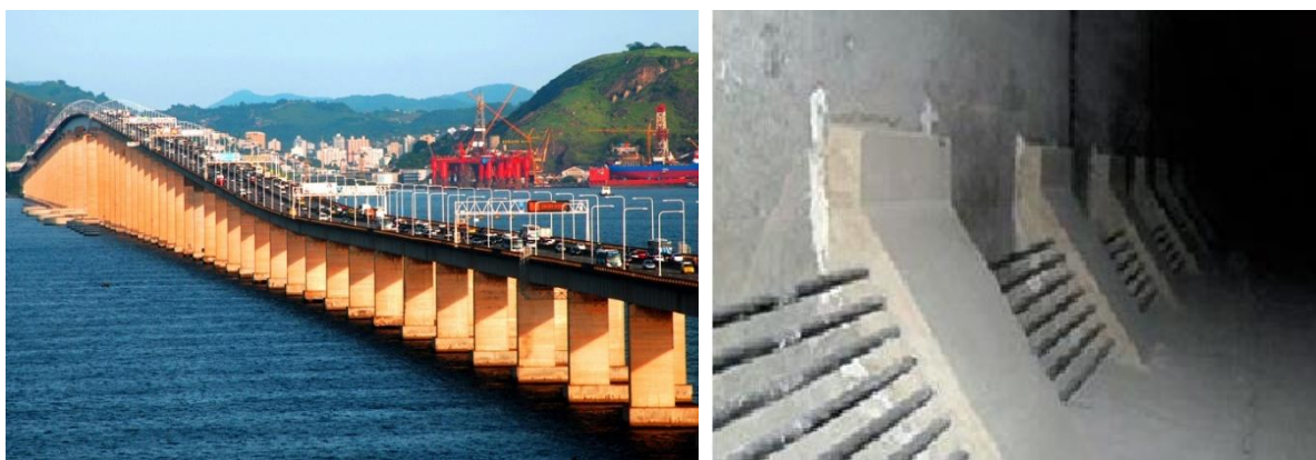
Figura 13 – Ponte Rio-Niterói, no Rio de Janeiro e ao lado, detalhe do reforço com protensão externa no interior de suas vigas caixão
