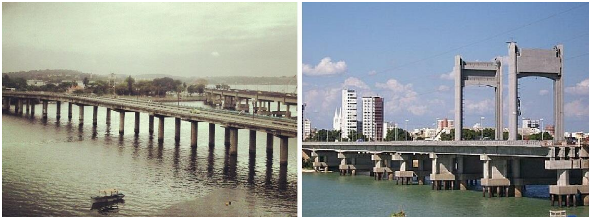
Figura 4 – À esquerda, a antiga Ponte do Galeão, no Rio de Janeiro; e à direita a Ponte Presidente Dutra, entre os estados de Pernambuco e Bahia
