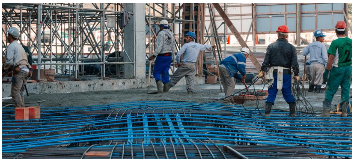
Figura 9 – Montagem das cordoalhas engraxadas em radier de edifício
