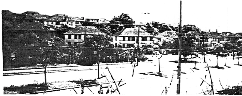
a) Área Sul - conjunto de edifícios "torre" compactos de dois pisos - Av. Plínio Brasil Milano - Porto Alegre/RS.
