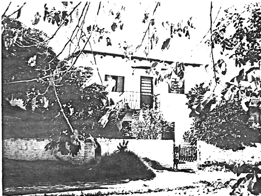
a) Casa 6m x 6m com 2 pisos - Rua Jackson de Figueiredo. (Os que menos tem, constroem com formas mais caras, com prejuízo da qualidade).
