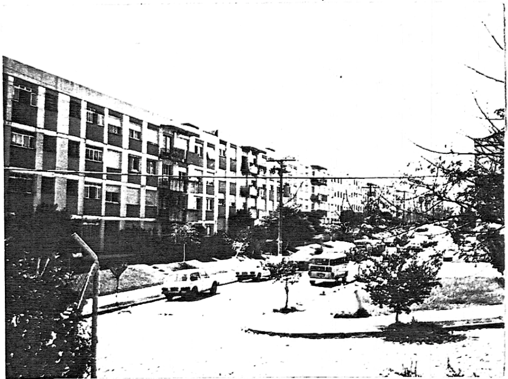
Fig.86 - Edifício "fita" (dupla) com 200m de comprimento, revestido com pastilhas cerâmicas. Bairro Cristo Redentor, Porto Alegre/RS.
