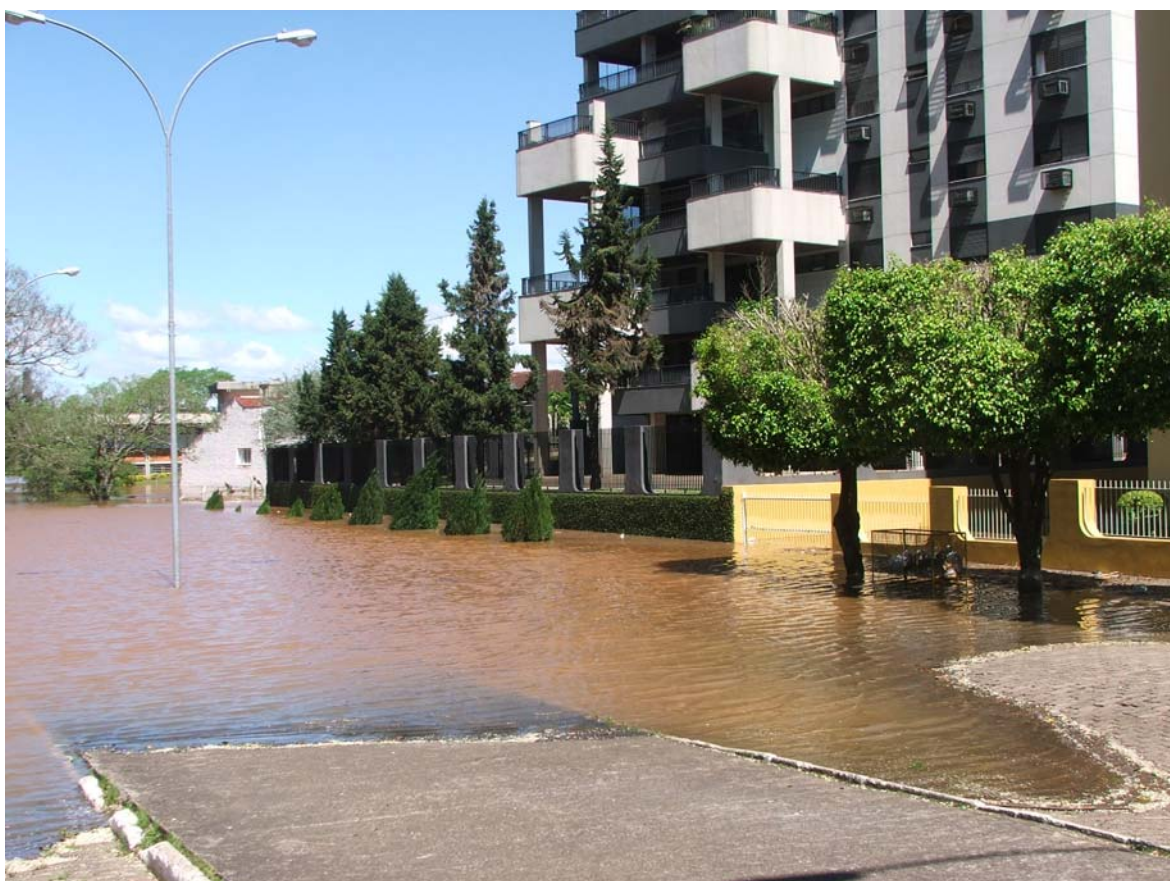
Figura 09 - Interrupção do tráfego pela inundação de 24 de setembro de 2007
