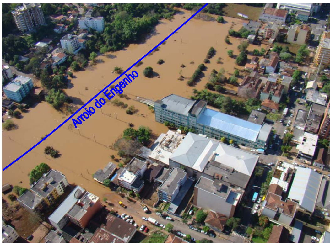
Figura 48 - Vista área em detalhe da inundação de 24 de setembro de 2007, ao longo do Arroio do Engenho
