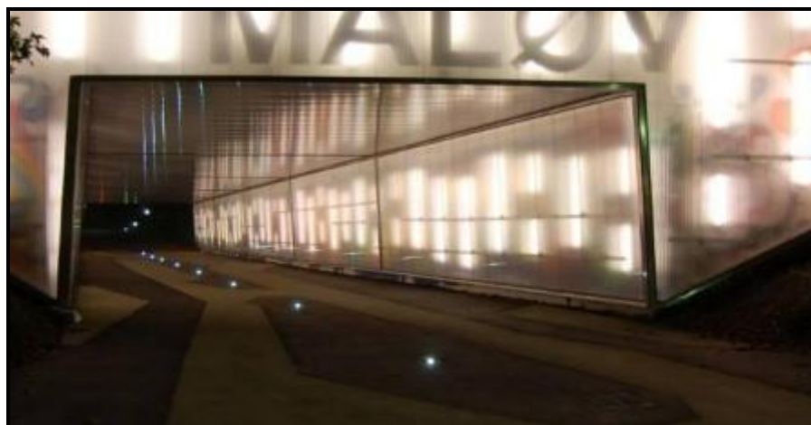
Figura 97 – Exemplo de via sinalizada com leds
