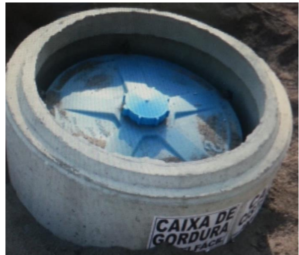
Figura 14 – Tanque plástico protegido por anel pré-moldado
