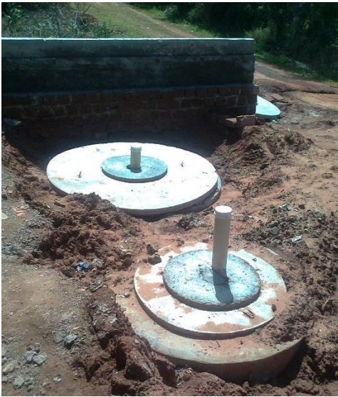
Figura 32 – Acessos de inspeção serão enterrados
