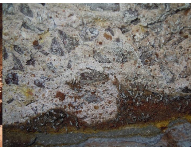
Figura 10 – Após remoção do material atacado em uma sobretampa
