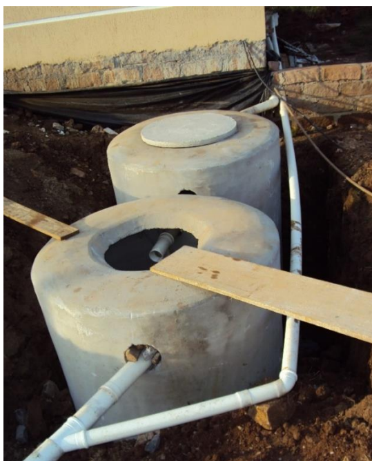
Figura 27 – Tubulação by-pass pelo sistema simplificado
