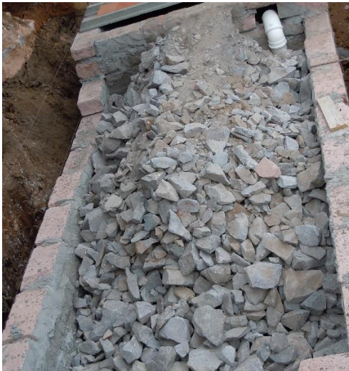
Figura 21 – Brita não-uniforme para preenchimento do filtro
