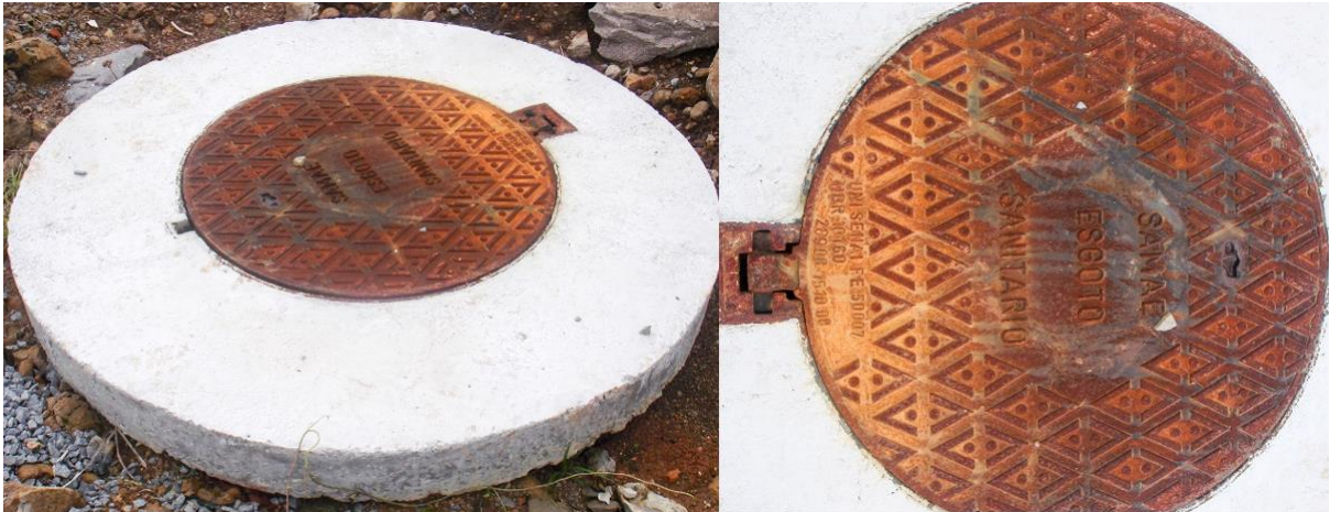
Figura 35 – Sobretampa de ferro fundido com inscrição
