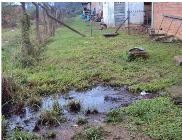
Figura 4 – Escoamento superficial do esgoto
