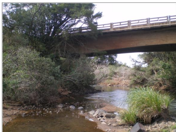
Figura 25 – Ponte Passo dos Buracos (seção do arroio foto 1)
