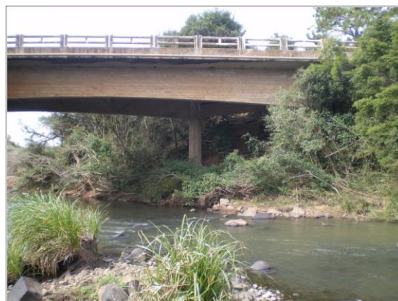
Figura 26 – Ponte Passo dos Buracos (seção do arroio foto 2)
