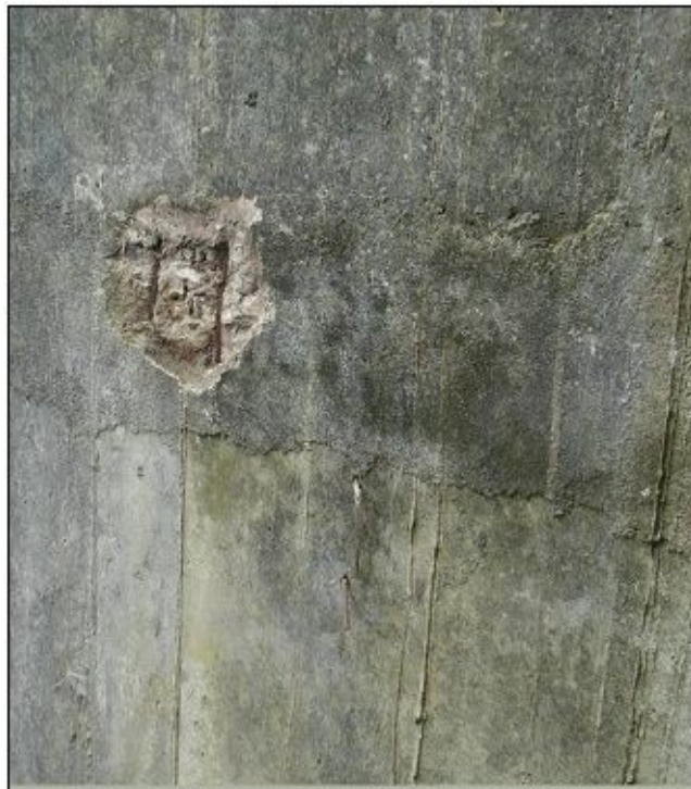
Figura 29 - Exemplo de deficiência no cobrimento das juntas horizontais
