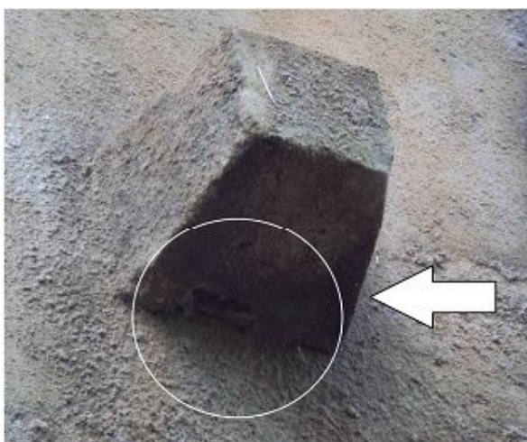
Figura 20 - Exemplo de exposição da placa do tirante
