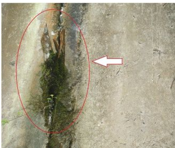
Figura 27 - Exemplo de vegetação nas juntas
