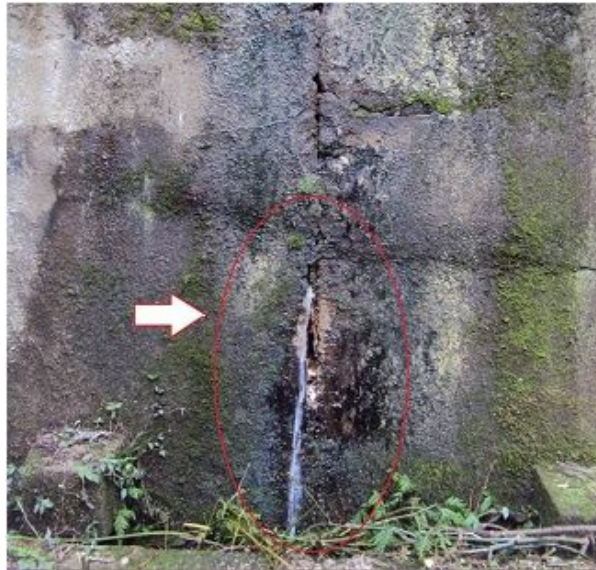
Figura 25 - Exemplo de surgência d'água
