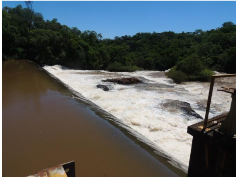
Figura 12. Vista a montante da barragem
