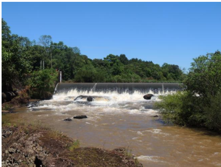
Figura 14. Vista a jusante da barragem
