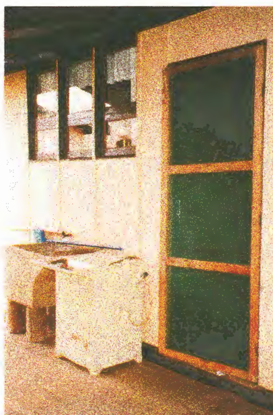
Figura 28: Exemplo de caixilho com tela adaptado à portas.
