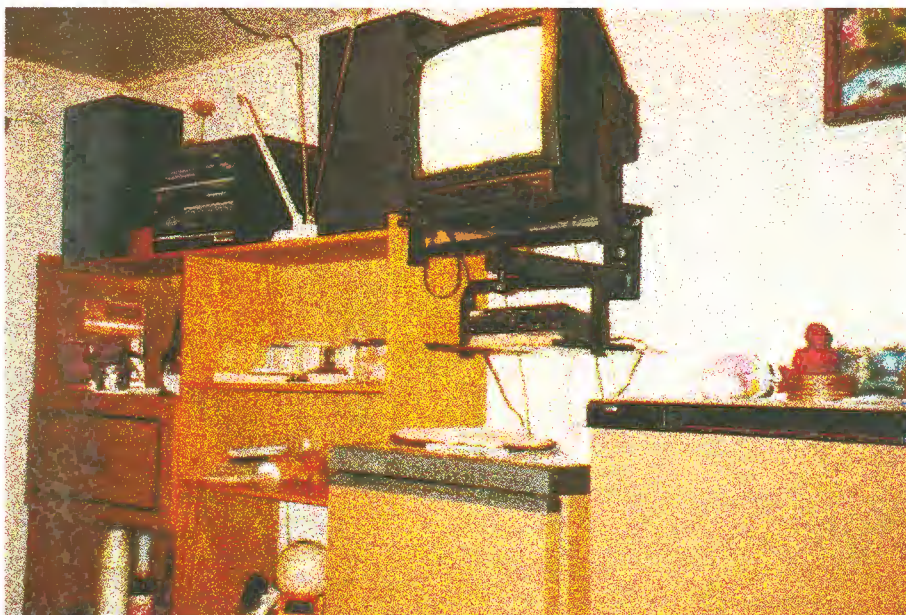
Figura 23: Exemplo de situação que exige mais tomadas do que as previstas originalmente no projeto.
