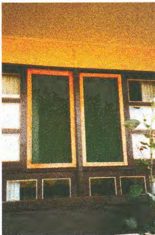
Figura 27: Exemplo de caixilho com tela adaptado à janelas.
