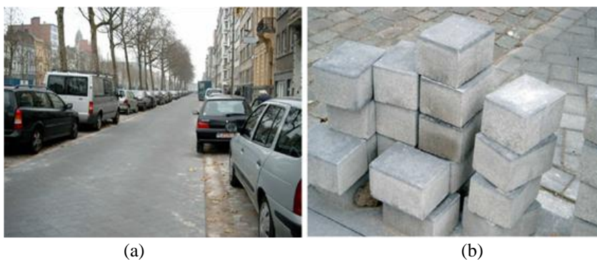
Figura 20 – Aplicação de pavers fotocatalíticos em Antuérpia, Bélgica: (a) via pavimentada (estudo-piloto) e (b) blocos utilizados
