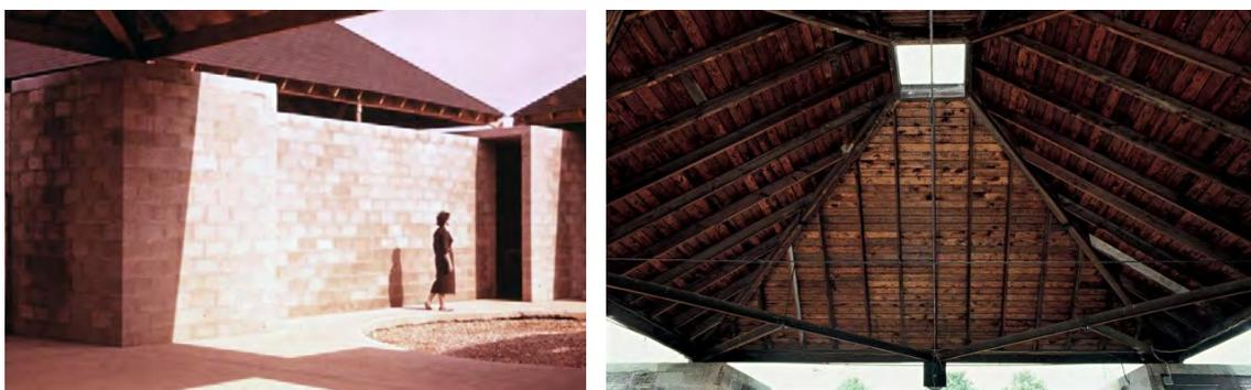
FIG 46 e 47 | Detalhe das paredes de blocos de concreto e da estrutura da cobertura piramidal [phaidon.com ]
