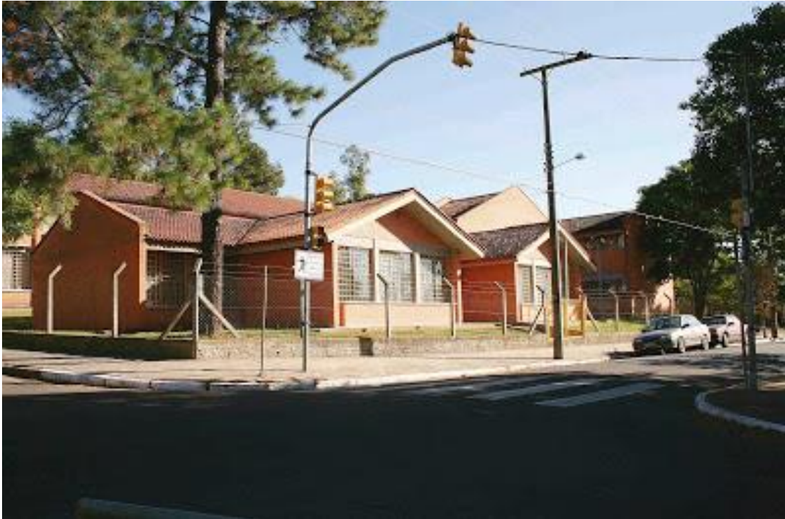
Figura 2 – Fachada da Escola Estadual de Ensino Médio Itália
