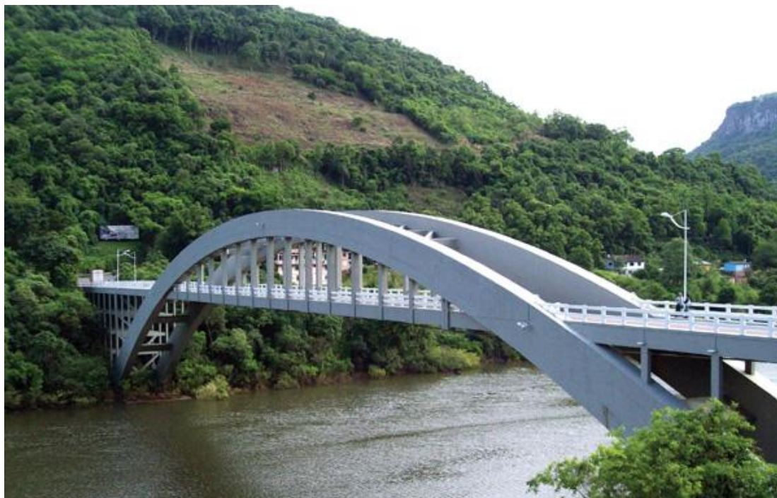
Figura 3 - Ponte sobre o Rio das Antas
