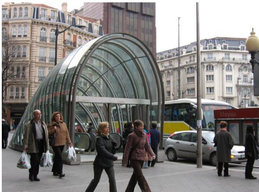
Figura 13 – Acesso de uma estação de Bilbao com mapas de localização
