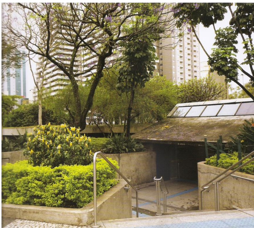
Figura 11 – Acesso da estação Paraíso em São Paulo
