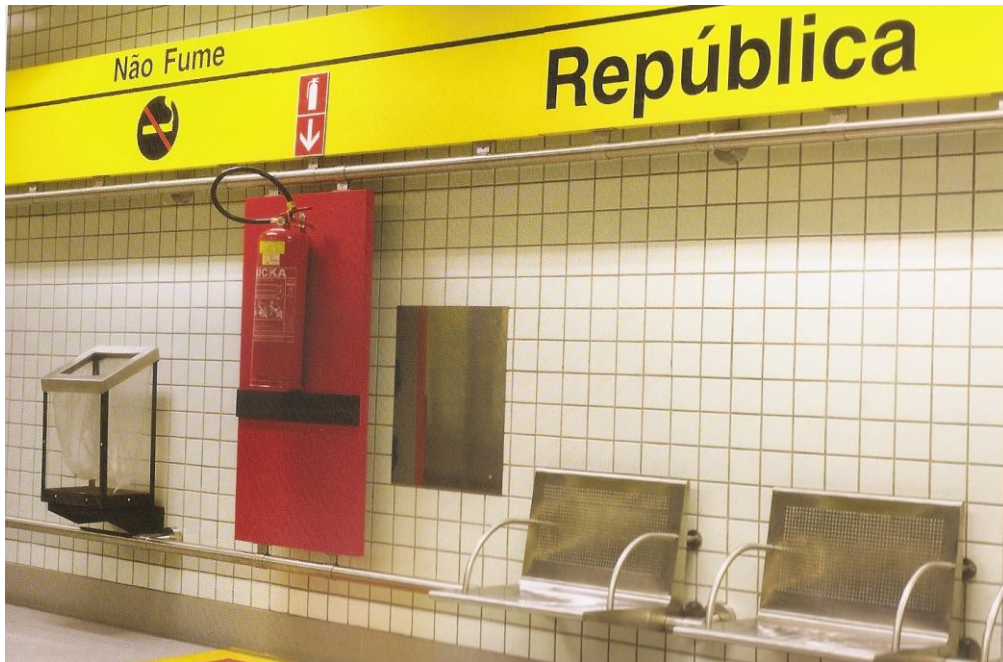
Figura 26 – Utilização de tubos de aço inox em plataforma da estação República
