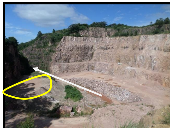
Figura 9. Deposição de material no interior da cava e canal de drenagem. Elaborado pelo autor (2015).
