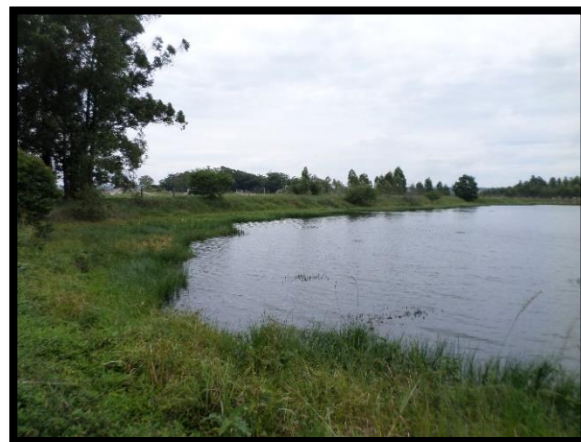
Figura 5. Revegetação de taludes realizada com sucesso. Elaborado pelo autor (2015).
