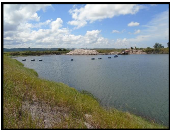
Figura 4. Talude em processo de recuperação. Elaborado pelo autor (2015).
