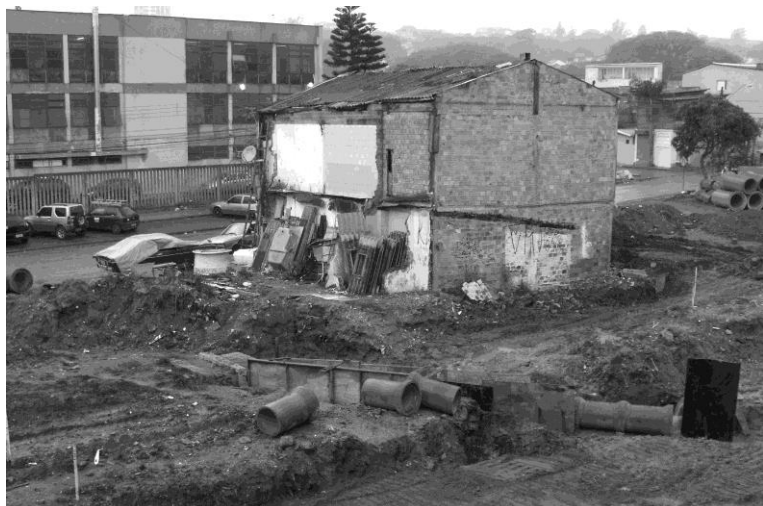
Figura 3.4 Casa remanescente em meio à obra. Vila Tronco. Fonte: Autora.
