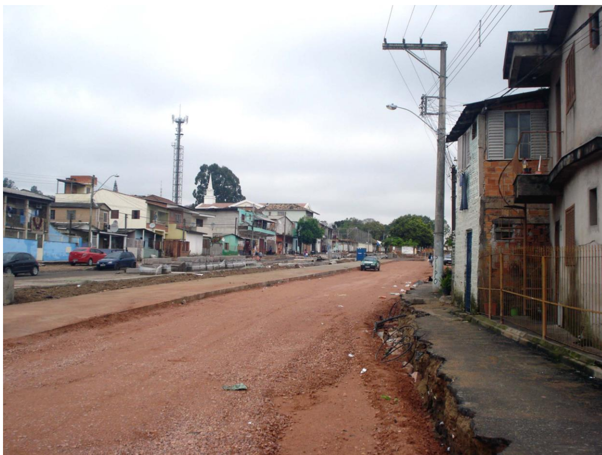
Figura 3.3 Trecho em obras. À direita, fachada remanescente da Vila Tronco. Fonte: Autora.
