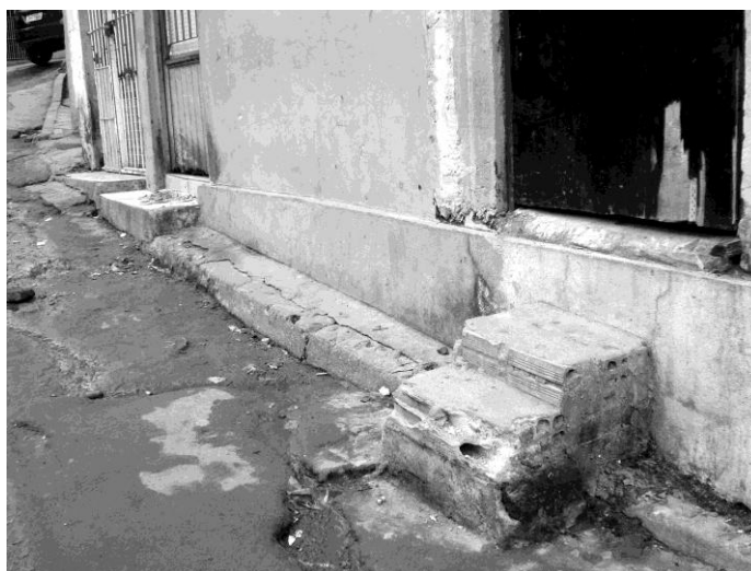
Figura 2.18 Soleiras. Vila Tronco. Fonte: Autora.
