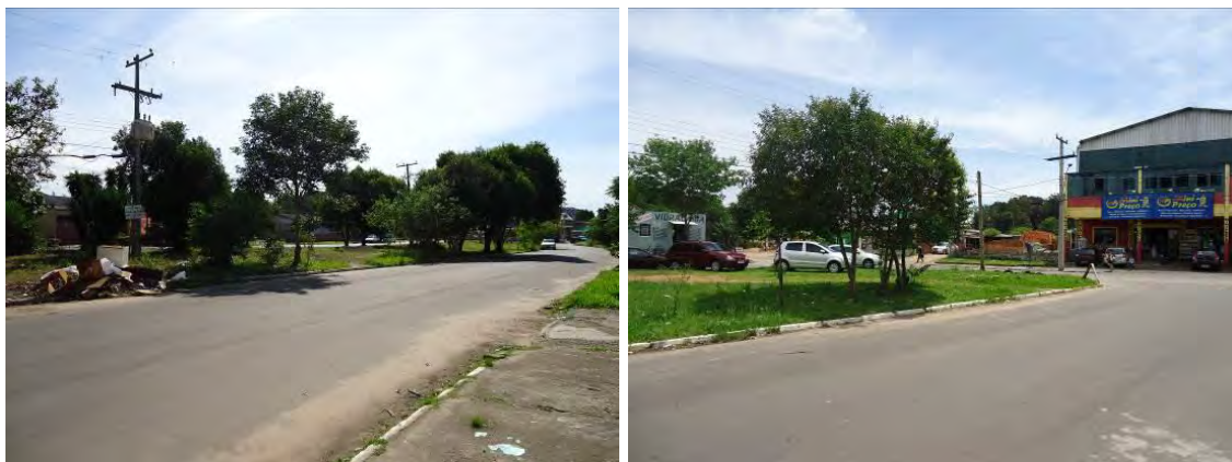
Figura 89: Fronteira entre a rua local e a unidade de vizinhança.
