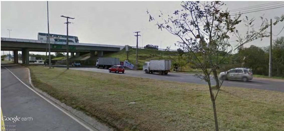
Figura 67: Trecho da Avenida Assis Brasil junto ao viaduto da BR 290.
