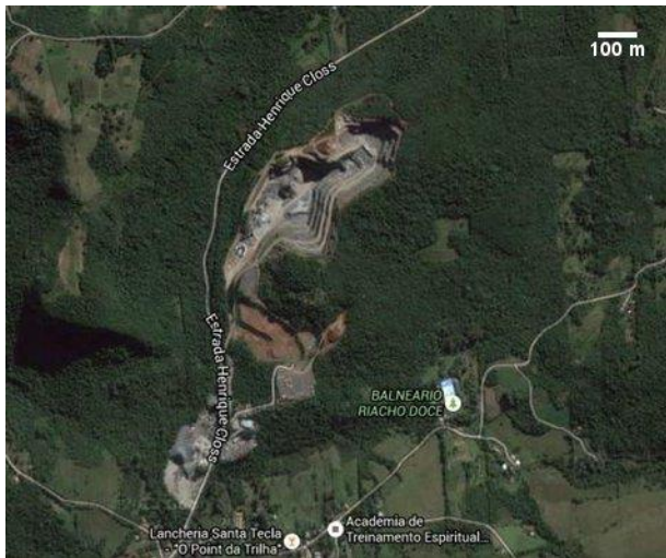
Figura 13. Lavra de diabásio da mineradora Pedraccon S.A., localizada em Gravataí/RS (Google Maps, 2016).
