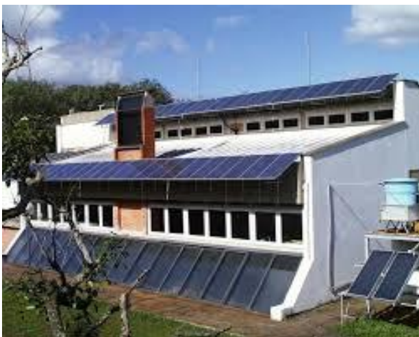
Figura 3.1 – SFCR de 4,8 kWpico – Laboratório de Energia Solar – LABSOL – UFRGS - RS.
