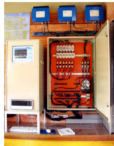
Figura 3.1 – SFCR de 4,8 kWpico – Laboratório de Energia Solar – LABSOL – UFRGS - RS.
