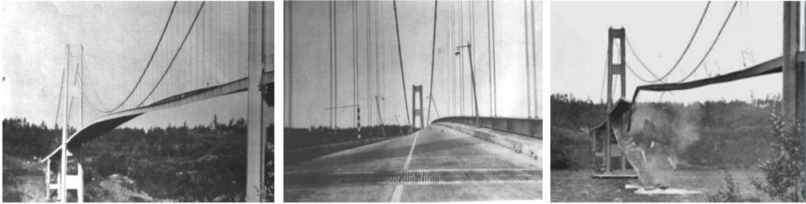
Figura 2.17 – Fotografias da ponte de *Tacoma Narrows* durante oscilação e no momento da sua ruptura.
