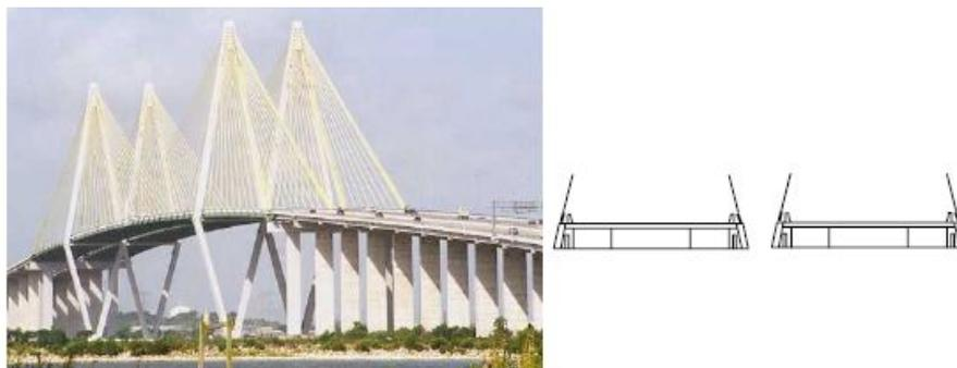
Figura 2.55 – Fotografia das pontes *Fred Hartmann* e secção transversal dos tabuleiros paralelos (Mashnad et al., 2005).
