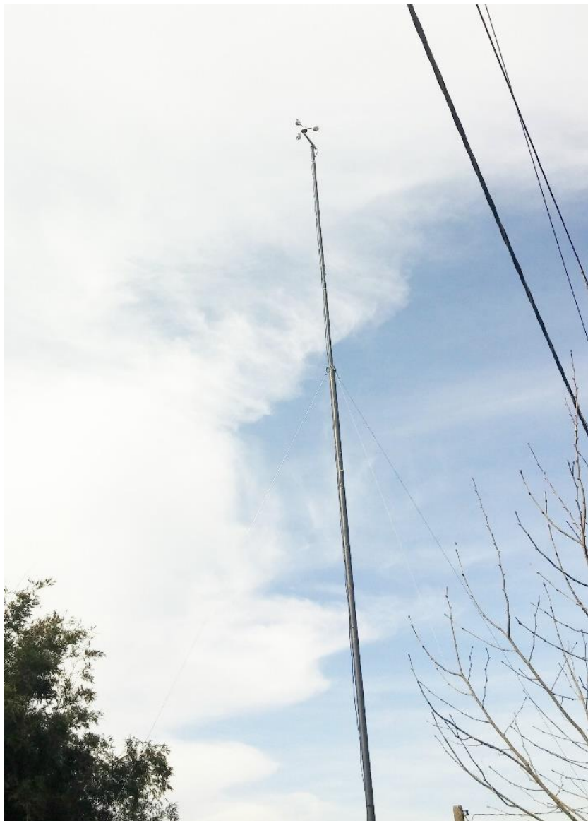
Figura 35: Instalação do anemômetro.
