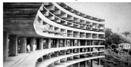
ABAIXO: Bloco A em construção.
