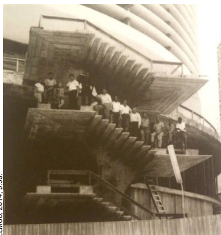
ACIMA: Fotografia de 20 de outubro de 1956, mostrando a escada de acesso ao terraço construída para substituir a rampa helicoidal proposta para o lugar.
