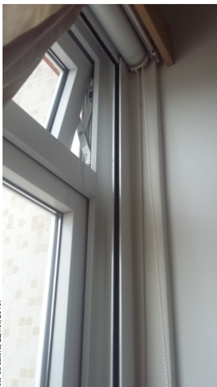
ABAIXO: Detalhe de esquadria anti-ruído com blakcoute acoplado para escurecimento do ambiente.
