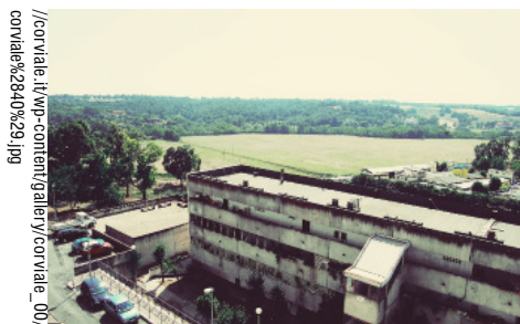
ABAIXO: Edifício de serviços básicos do Corviale desde o edifício principal e a área de campo a qual separa da cidade.
