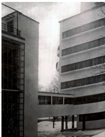
ACIMA: Fotografia da passarela entre o Bloco residencial e o Bloco de atividades comunais.
