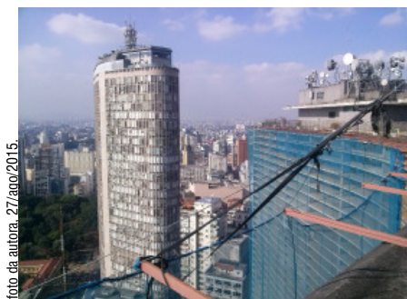
foto da autora, 27/ago/2015. ACIMA: Fotografia tirada desde a cobertura do Copan, com destaque para o Edifício Itália.
