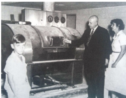
ABAIXO: Prefeito Mendes de Moraes e a engenheira Carmen Portinho inspecionando o maquinário da lavanderia importado da Alemanha.
