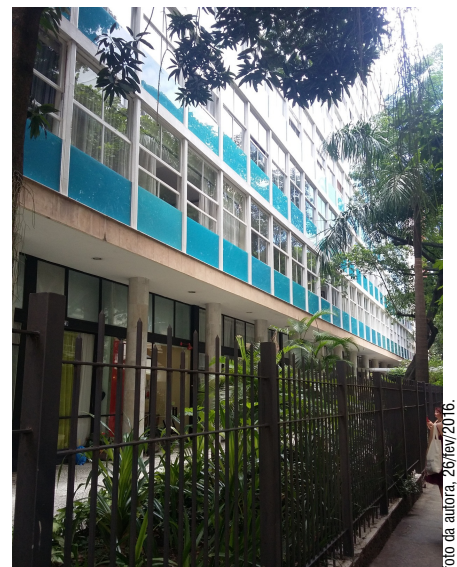
ACIMA: Fachada do edifício Nova Cintra, em fevereiro de 2016, apesar de restaurado, com as grades.
