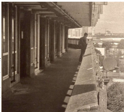
ABAIXO: Fotografia de uma das vias elevadas do Conjunto Robin Hood Gardens.
