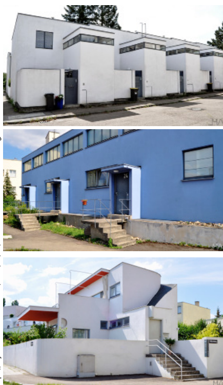
ACIMA: Fotografia dos edifícios projetados por J.J.P. Oud, Mart Stam e Hans Scharoun, respectivamente.
