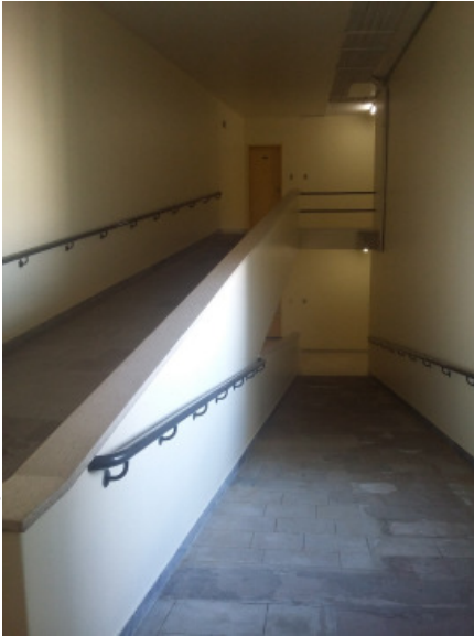
ACIMA: Esquema de rampas usado por Niemeyer no Copan para diminuir o número de paradas dos elevadores.
