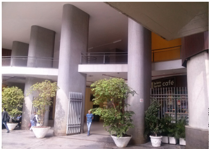
AO LADO: Fotografia de um dos acessos do térreo do Copan. Agosto de 2015.
