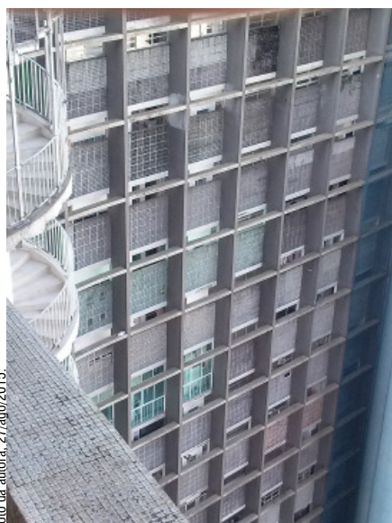
148 foto da autora, 27/ago/2015. ACIMA: Fotografia tirada desde a cobertura do Copan, mostrando modificações na fachada posterior do edifício.
