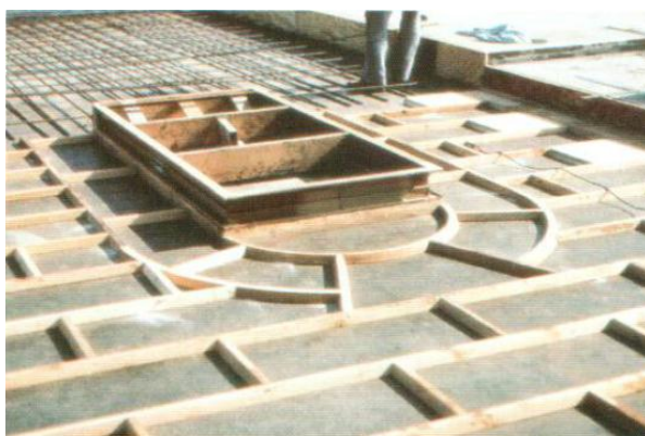
Figura 9 – Aberturas e detalhes instalados na laje
