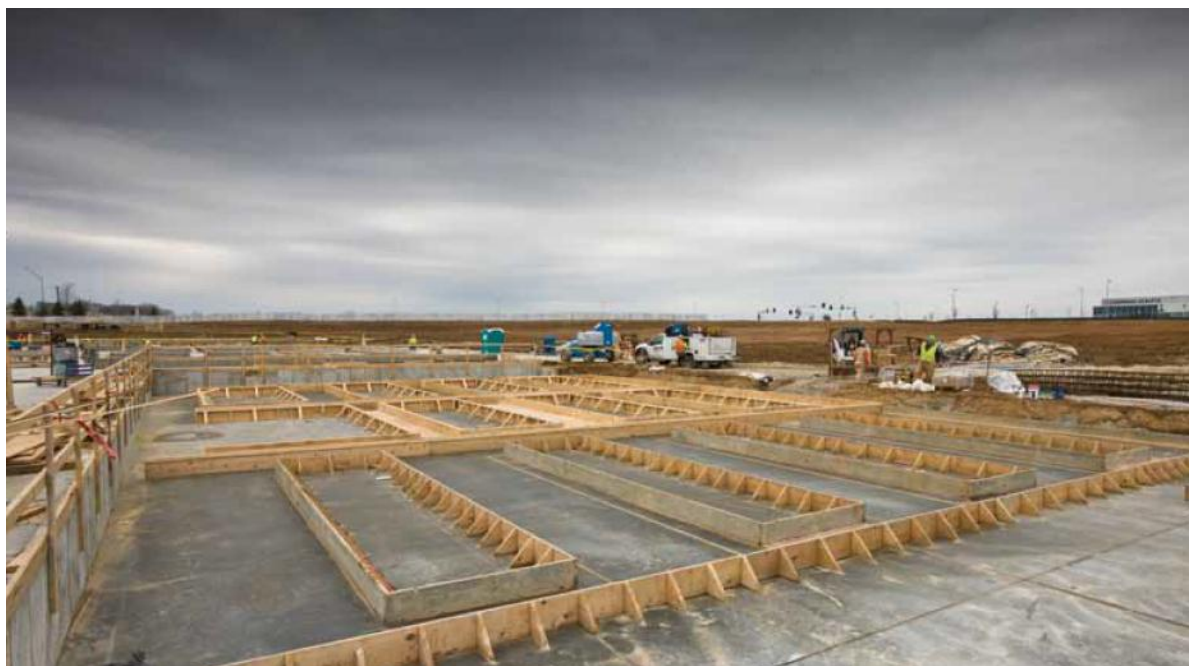
Figura 6 – Montagem das formas sobre o piso
