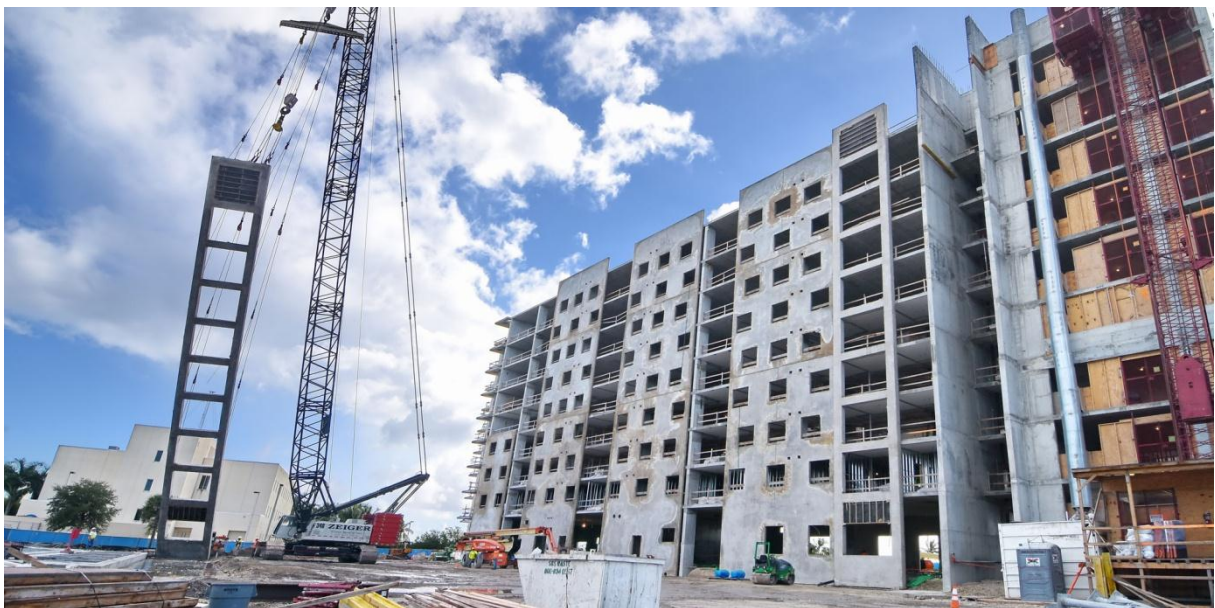
Figura 2 – Construção do edifício dormitório da Florida International University
