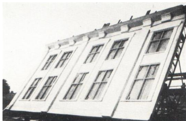
Figura 4 – Uma parede sendo levantada para o refeitório de Camp Perry
