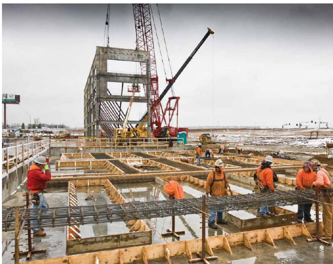
Figura 7 – Posicionamento das armaduras nas formas
