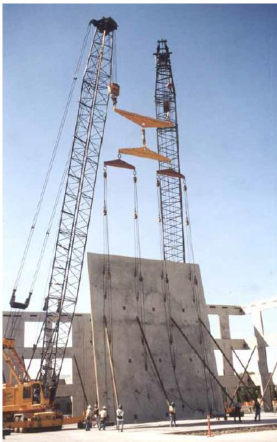
Figura 8 – Içamento de um painel por dois guindastes
