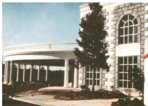
Figura 10 – Edificação pronta com os painéis pintados imitando blocos
