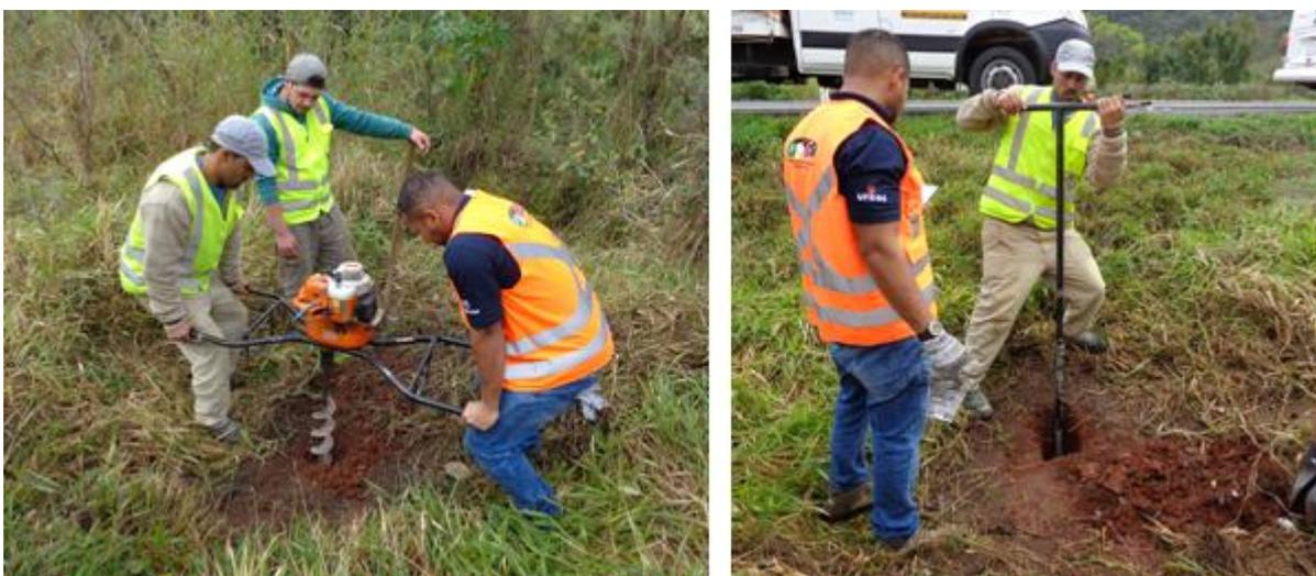
Figura 24: Realização do furo para instalação do medidor de nível d'água
