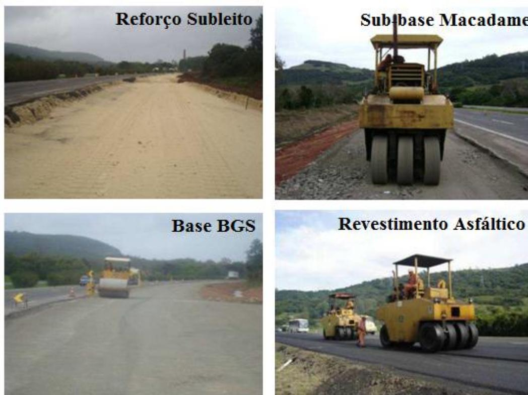
Figura 14: Principais etapas de execução dos trechos experimentais da BR-290/RS (Adaptado de Mattos, 2014)
