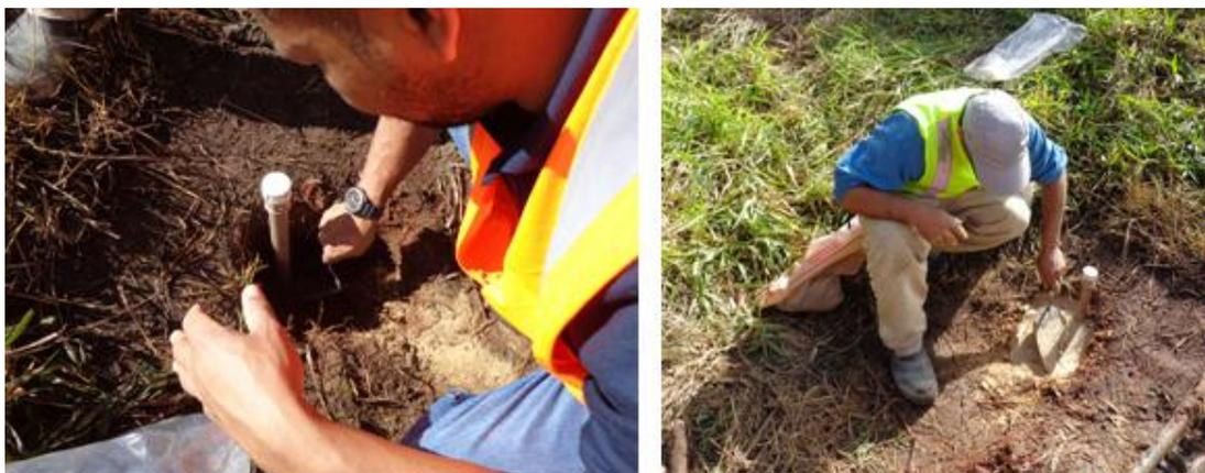
Figura 25: Preenchimento do restante do furo com areia e selamento com bentonita e água
