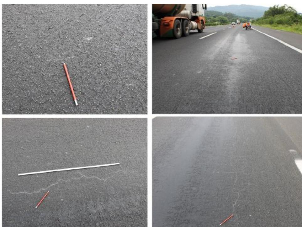
Figura 54: Aspecto da superfície de rolamento após a execução da camada de microrrevestimento asfáltico no Trecho I, com mais de três anos de monitoramento (Bock, 2016)
