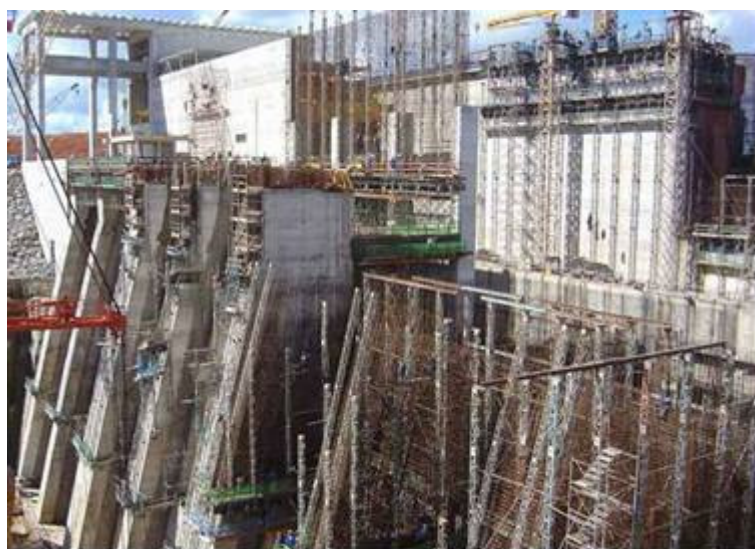
Figura 4: Vista da Casa de Força -Tomada d'água à Jusante (Arquivo FURNAS).
