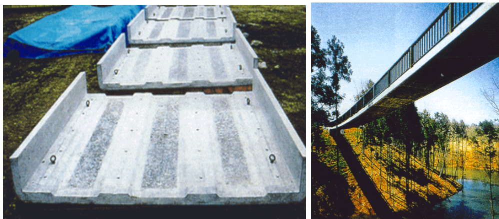
Figura 7. Ponte Birdie, fabricada com tendões CFCC (Ibaraki Prefecture, Japão) [Karbhari, 1998].
