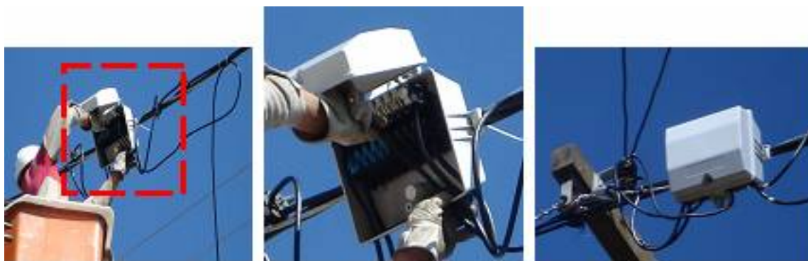
Fig. 7, 8 e 9 – Caixa de distribuição para cabos concêntricos e bi-concêntricos.
