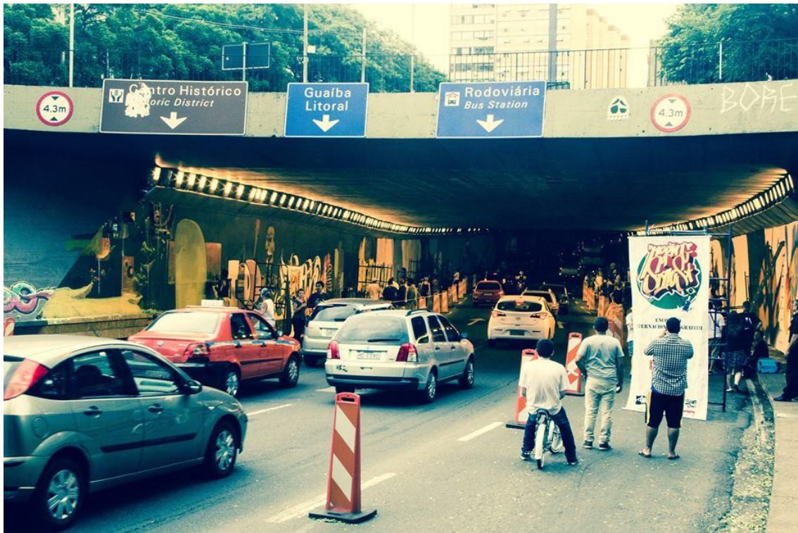
Imagem 4: Trânsito teve alterações, a velocidade máxima foi de 30 km/h durante o MOV. Foto: João Laud/RBS TV
