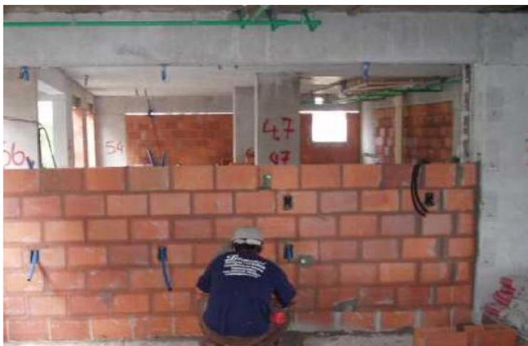
Figura 9. Edificação construída no sistema de alvenaria racionalizada [autora, 2016]
