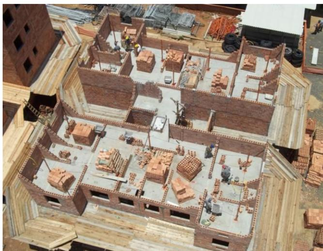
Figura 8. Edificação construída no sistema de alvenaria estrutural [autora, 2016]
