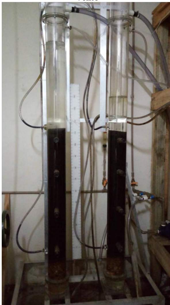
Figura 4.2 – As duas colunas experimentais piloto existentes na ETA Moinhos de Vento
