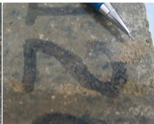
Figura 109: CP40 aos 1421 dias de idade: superfície do concreto esfarelado ou desintegrando.
