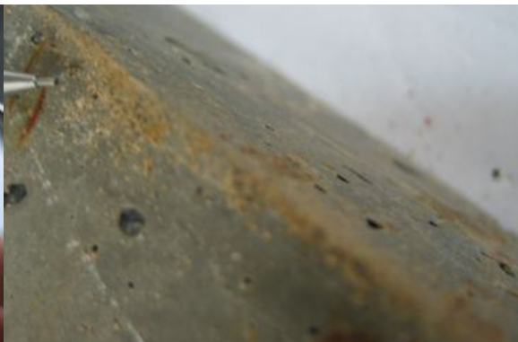
Figura 111: CP60 aos 1653 dias de idade: aresta do prisma de concreto coberta por produtos de coloração marrom, indicando deterioração da pasta de cimento.
