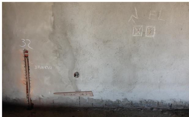
Figura 62 - Uso de marcações na parede com giz
