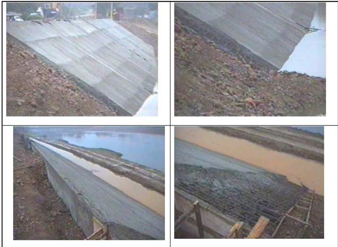
Figura 3.44: Painéis em concreto armado (Fonte: BRIGHETTI & MARTINS, 2001).
