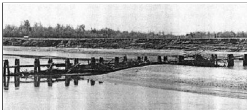
Figura 3.46: Espigão de proteção, com retenção de material flutuante, Rio Arkansas. (Fonte: BRIGHETTI & MARTINS, 2001).
