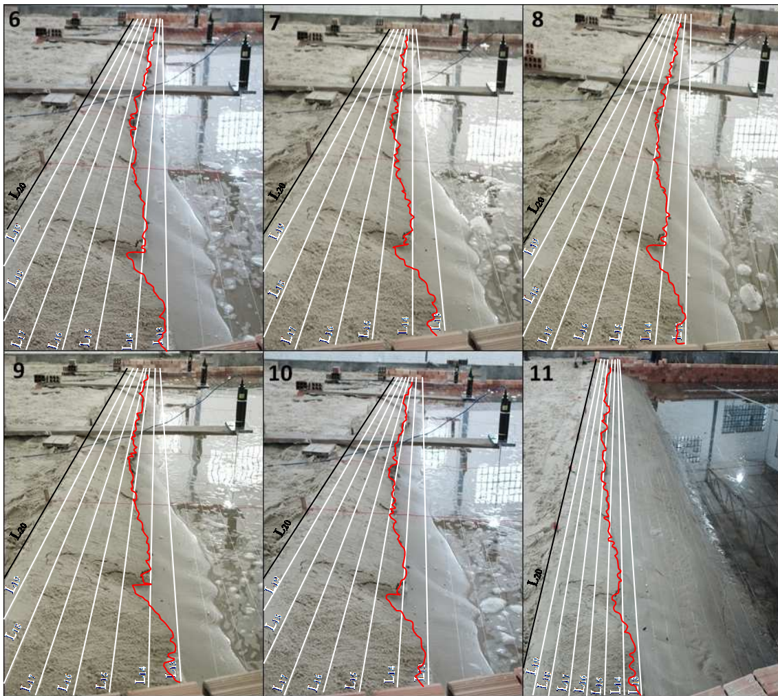
(b) Talude de proteção após os testes T 6 a T 11 .
