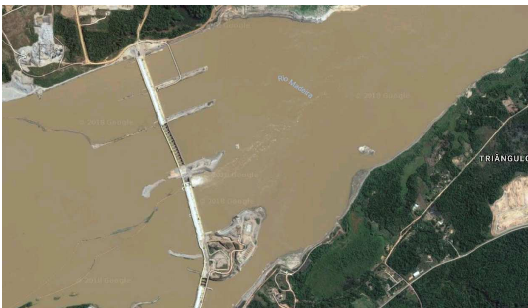
Figura 1.4 - Imagem aérea da Usina Santo Antônio (Fonte: Imagem Google Maps (2018)).
