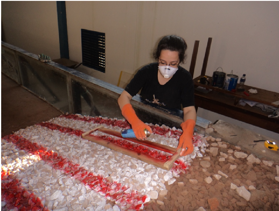
Figura 4.22 – Marcação das listras longitudinais no talude com tinta vermelha.
