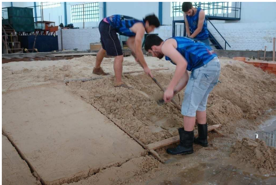
Figura 4.36 - Colocação do gabarito de madeira para confecção da superfície do talude.
