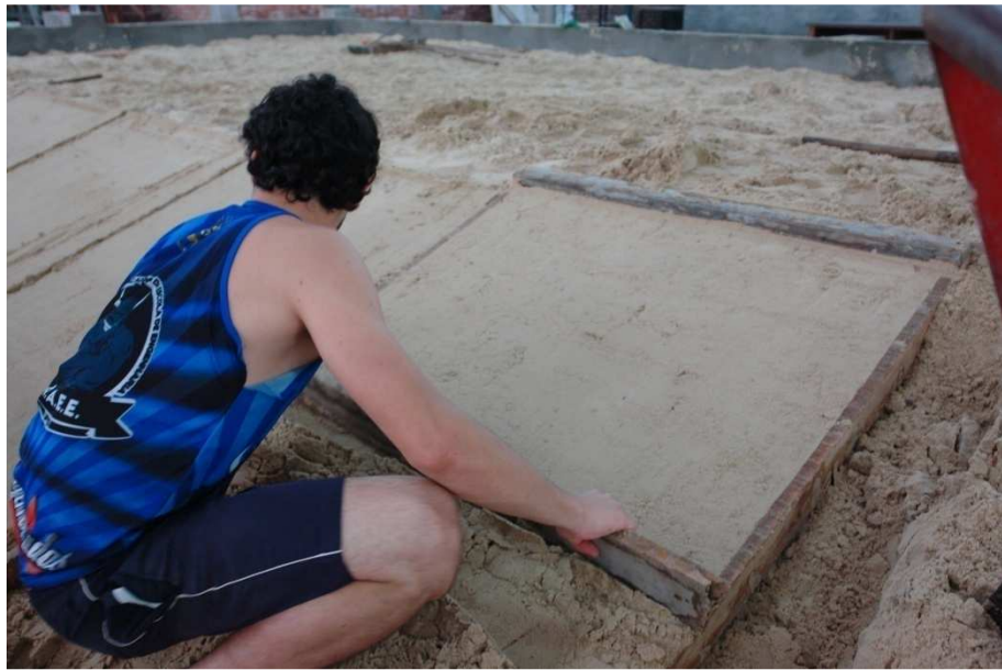
Figura 4.38 - Nivelamento da superfície do talude.
