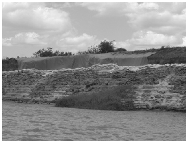
Figura 3.48: Contenção de talude marginal com sacos de areia, nas proximidades do município de Brejo Grande/SE. (Fonte: HOLANDA et al. , 2009).
