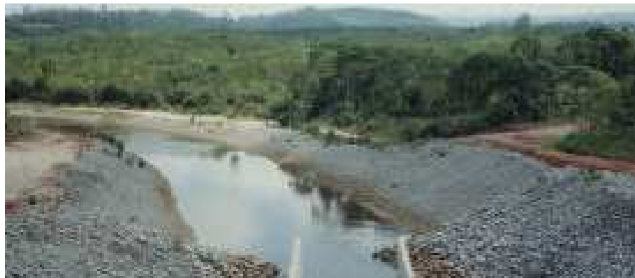
Figura 3.42: Enrocamento granítico utilizado como proteção de margem de canal de adução de água. Sistema Alto Tietê (BRIGHETTI & MARTINS, 2001).
