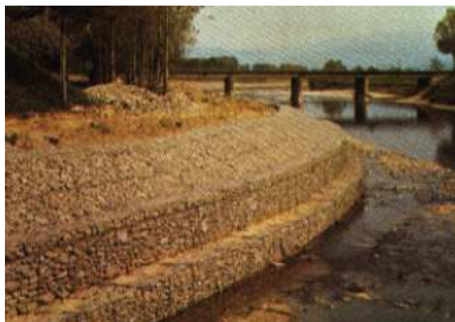
Figura 3.43: Revestimento de Margens com Gabiões para proteção contra ondas. (Fonte: BRIGHETTI & MARTINS, 2001).
