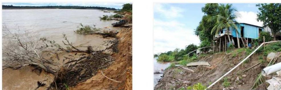
Figura 1.5 - Barrancos da margem direita do Rio Madeira - RO. (Fonte: PEREIRA et al. , 2015).
