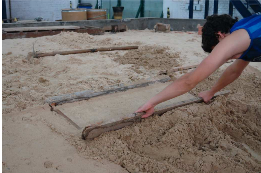
Figura 4.37 - Início do nivelamento da superfície do talude.
