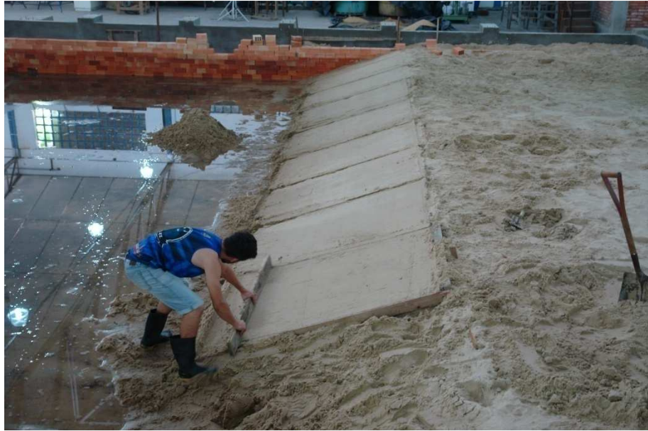
Figura 4.39 - Nivelamento da superfície do talude.
