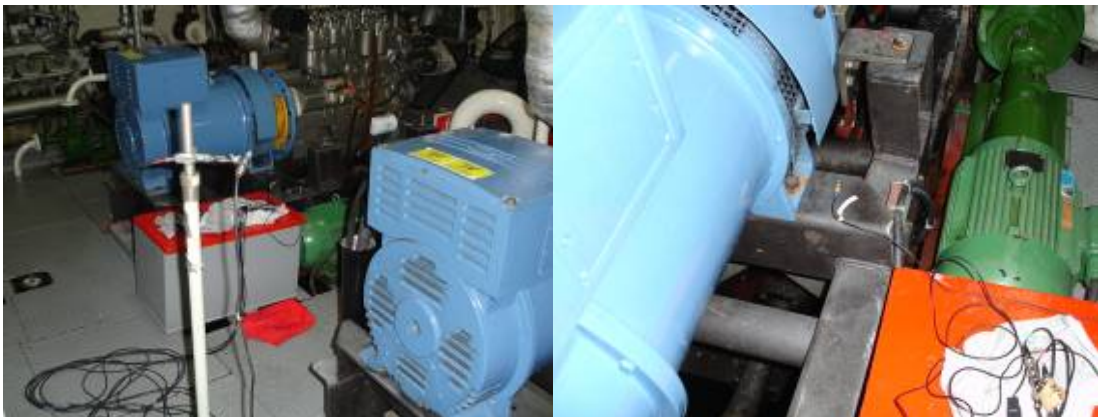
Figura 5.11 – Ponto de medição na praça de máquinas no Gerador Esquerdo - GE.
