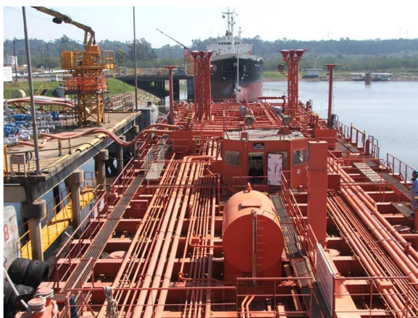
Figura 4.2 – Vista dos tanques de carga desde a sala de comando.
