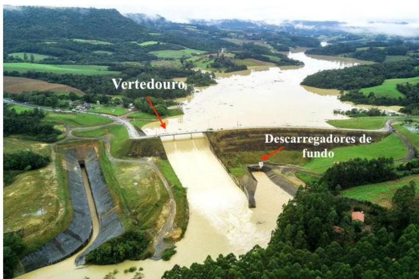
Figura 5 – Imagem aérea da Barragem Sul (Adaptada de DIÁRIO CATARINENSE (2017)).
