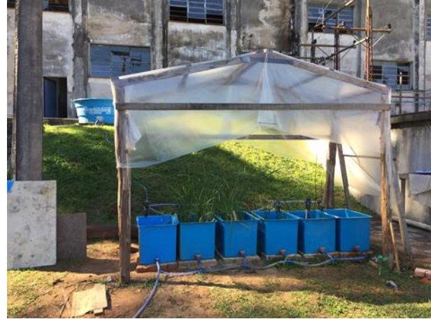
Figura 7. Vista frontal da unidade experimental de um sistema flutuante de wetland construído em mesocosmos no IPH/UFRGS (23 de agosto de 2017)
