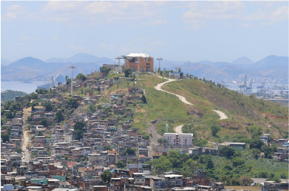
Figura 8 - Muros controlam fluxo de pessoas no Complexo do Alemão
