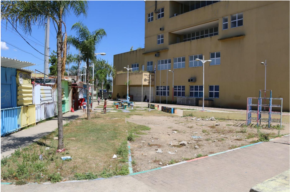
Figura 6 - Moradores reclamam do isolamento sem teleférico no Complexo do Alemão
