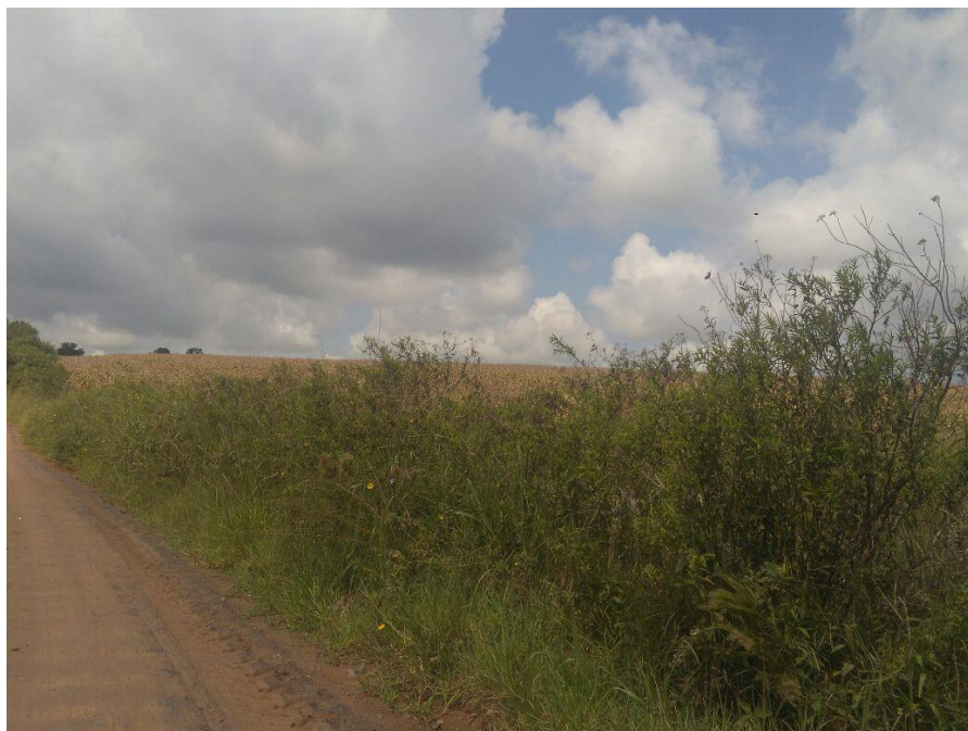
Foto 13 – Fonte: foto do autor (2017). Aspecto da estrada no assentamento Itapuí.
