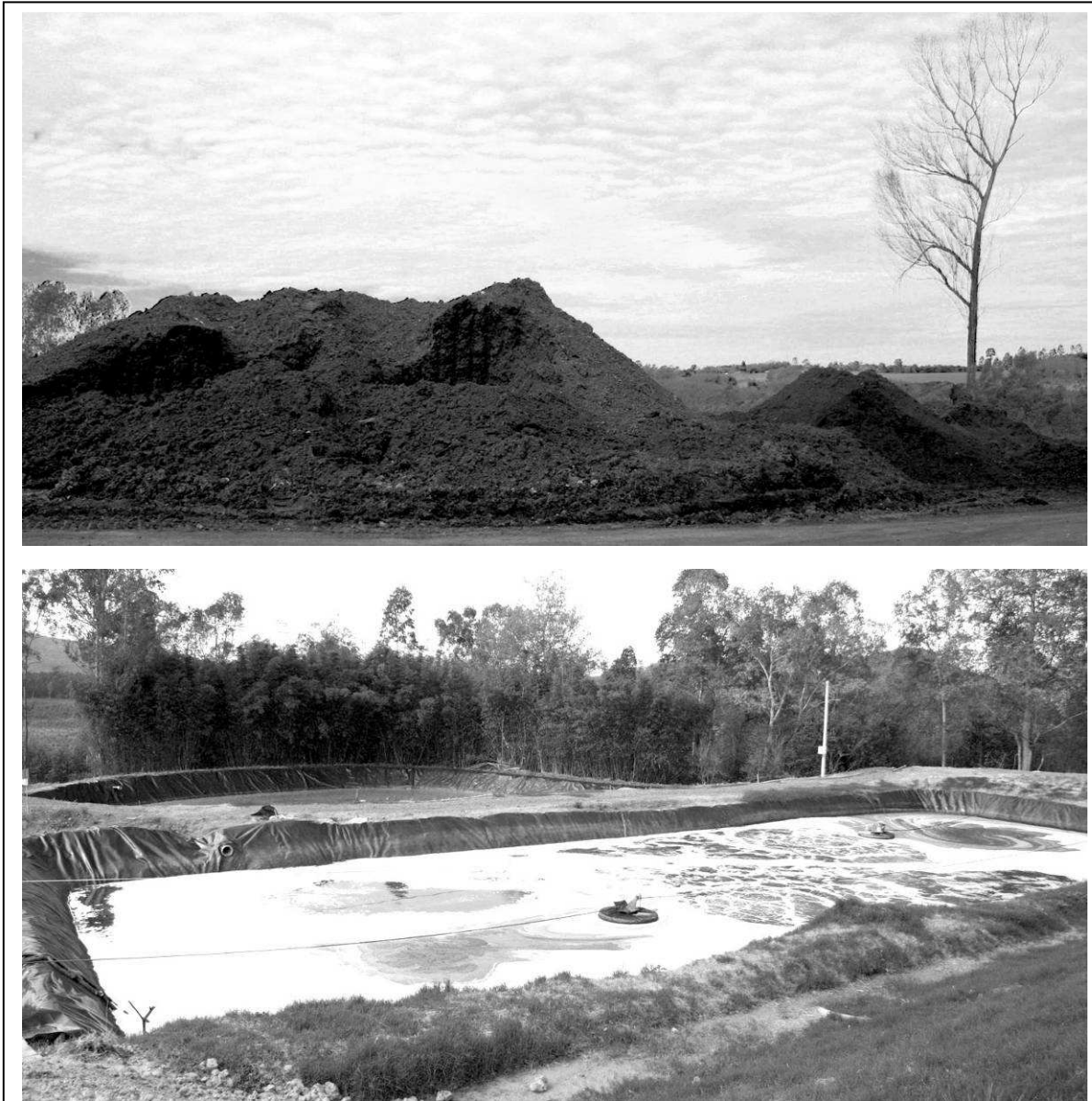
FIGURA 3: Imagem superior mostrando o composto já em estágio avançado e imagem inferior mostrando uma lagoa de tratamento dos efluentes provenientes do processo de compostagem (julho/2008 – fotografia da autora).
