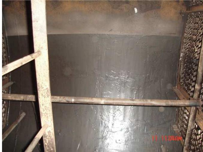
Figura 4.7 Revestimento epóxi novolac aplicado internamente em Separador de produção da P-26.
