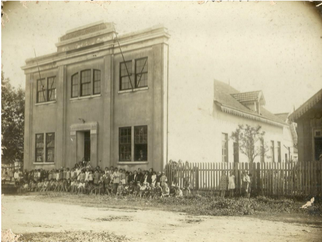
Figura 4: Chalê reformado da Av. Maranhão
