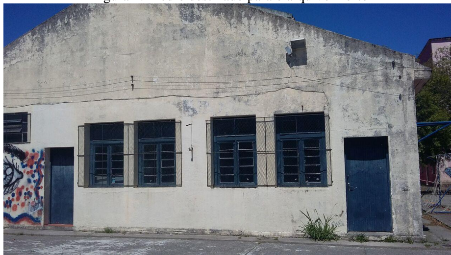
Figura 1: Prédio destinado para o arquivo morto
