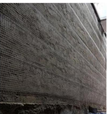
Figura 14 – Manta posicionada
