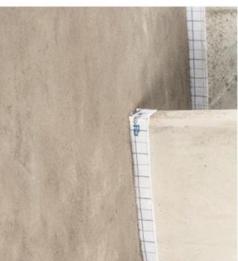
Figura 16 – Execução do arremate no encontro de paredes
