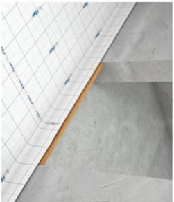
Figura 7 – Execução da virada da manta junto a soleira das portas
