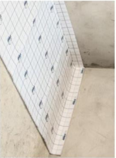
Figura 4 – Posicionamento da manta e execução das viradas junto aos elementos de vedação
