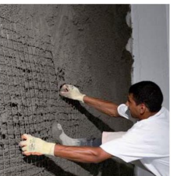
Figura 14 – Manta posicionada
