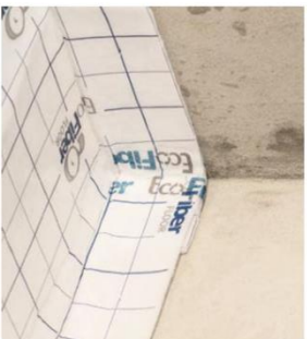
Figura 5 – Execução do arremate no encontro de paredes
