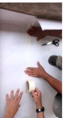
Figura 6 – Execução da emenda das mantas com fita indicada pelo fabricante
