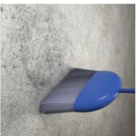
Figura 3 – Limpeza da poeira e dos resíduos sob a laje
