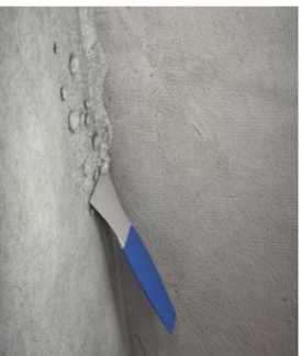
Figura 1 – Remoção dos resíduos de concreto e de argamassa
