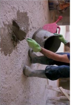
Figura 2 – Preenchimento de irregularidades na laje
