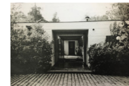
Figura 99 — Entrada da Casa Sergio Larraín.
