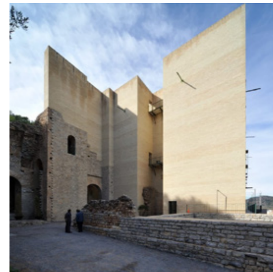
Figura 24 — Teatro Sagunto: Novo material, na expansão da área, remontando à estrutura original que não mais existia.
