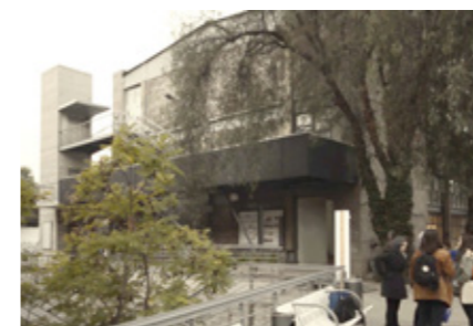
Figura 72 — Edifício de laboratórios visto a partir do centro do campus.
