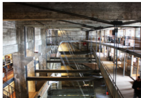
Figura 23 — Reforma na Sala de Máquinas da Faculdade de Engenharia - UDELAR.
