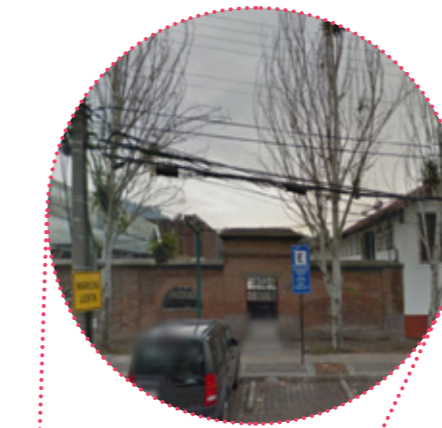
Figura 44 — Muro de tijolos na borda oeste, remanescente do projeto de reforma de 1915.
