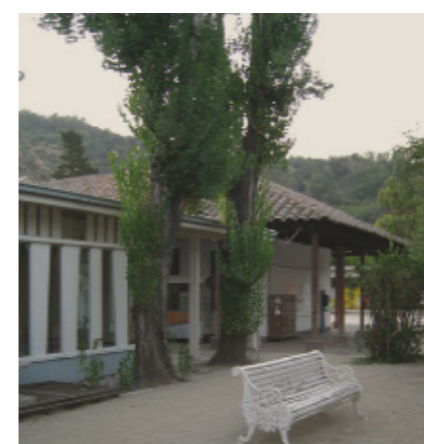
Figura 87 — Nova cantina, anexada à casona.
